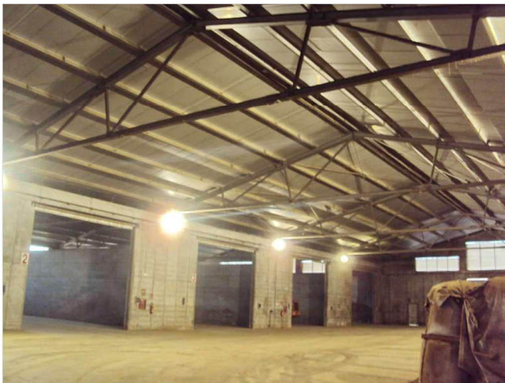
Foto n. 45: Interno corpo H1
