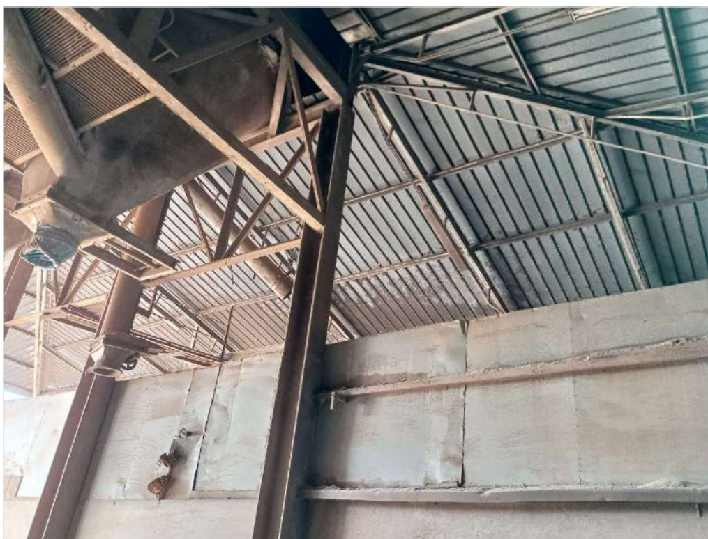
Foto n. 29: Interno corpo E1
