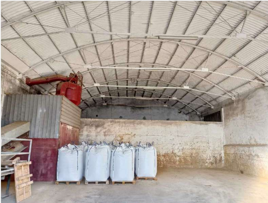
Foto n. 19: Interno corpo B2
