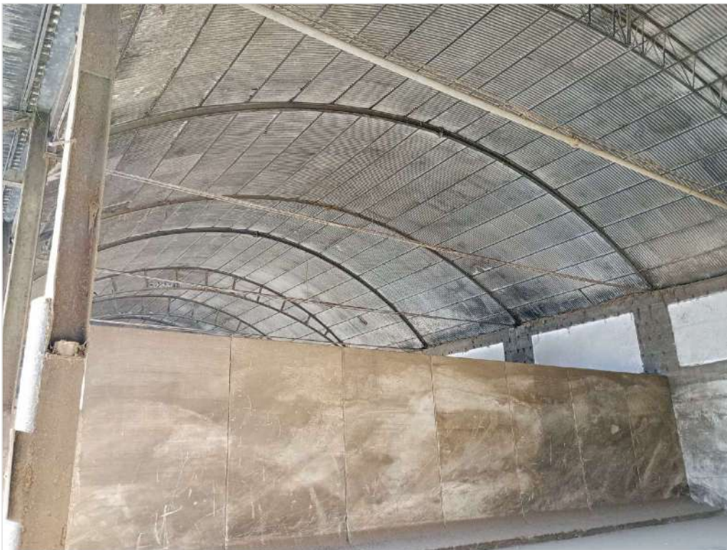
Foto n. 38: Interno corpo G1
