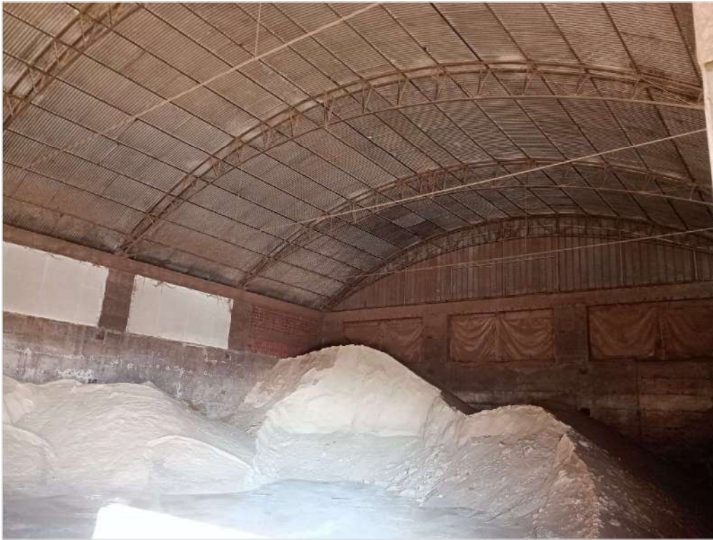
Foto n. 37: Interno corpo G1
