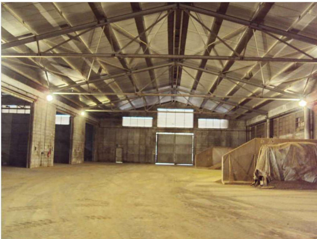
Foto n. 44: Interno corpo H1
