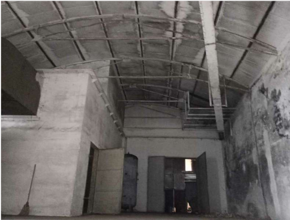
Foto n. 17: Interno corpo B1 primo piano
