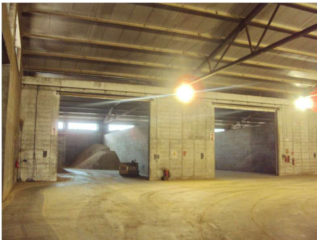
Foto n. 46: Interno corpo H2
