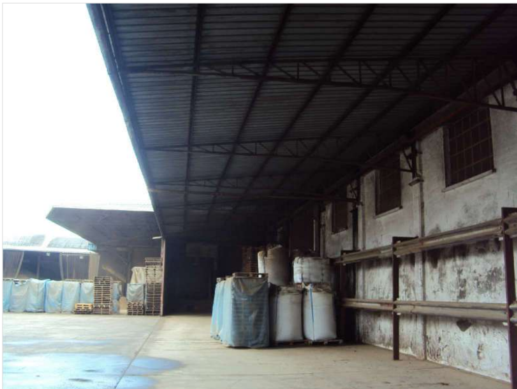
Foto n. 22: Pensilina C2 lato ovest
