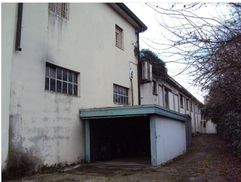
Foto n. 49: Box autorimessa adiacente al fabbricato A
