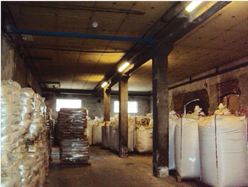
Foto n. 5: Interno corpo A1
