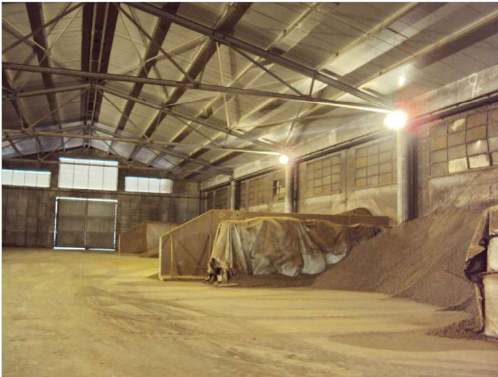
Foto n. 43: Interno corpo H1
