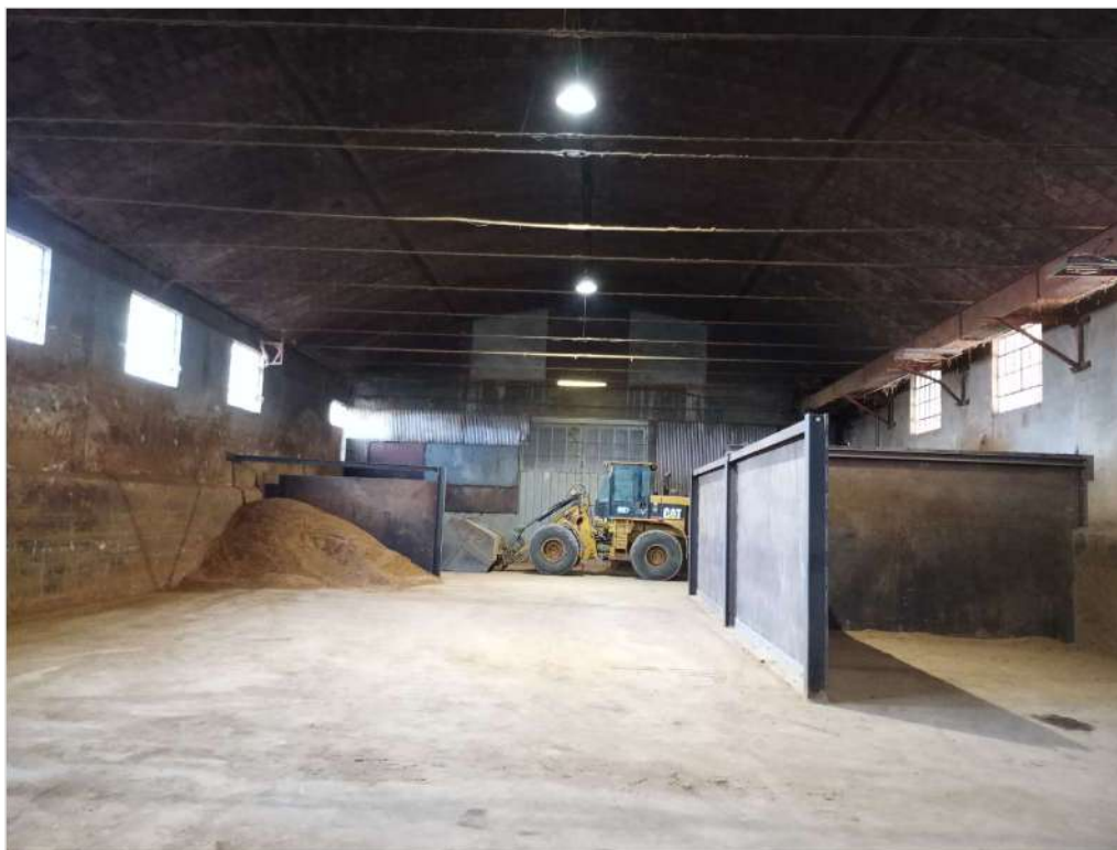
Foto n. 24: Interno corpo C1
