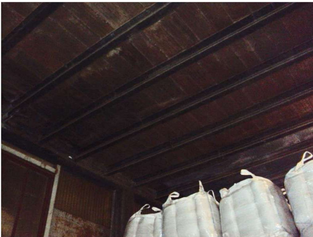
Foto n. 8: Interno corpo A1
