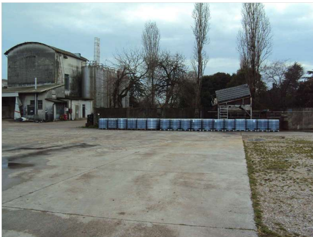
Foto n. 54: Area scoperta lato sud
