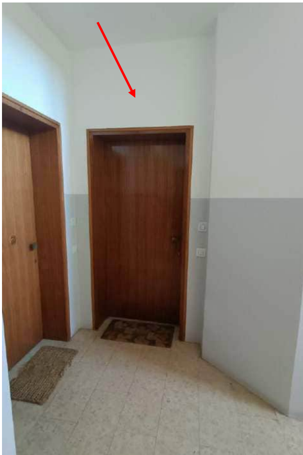
Foto 11 – Portoncino ingresso vista esterna
