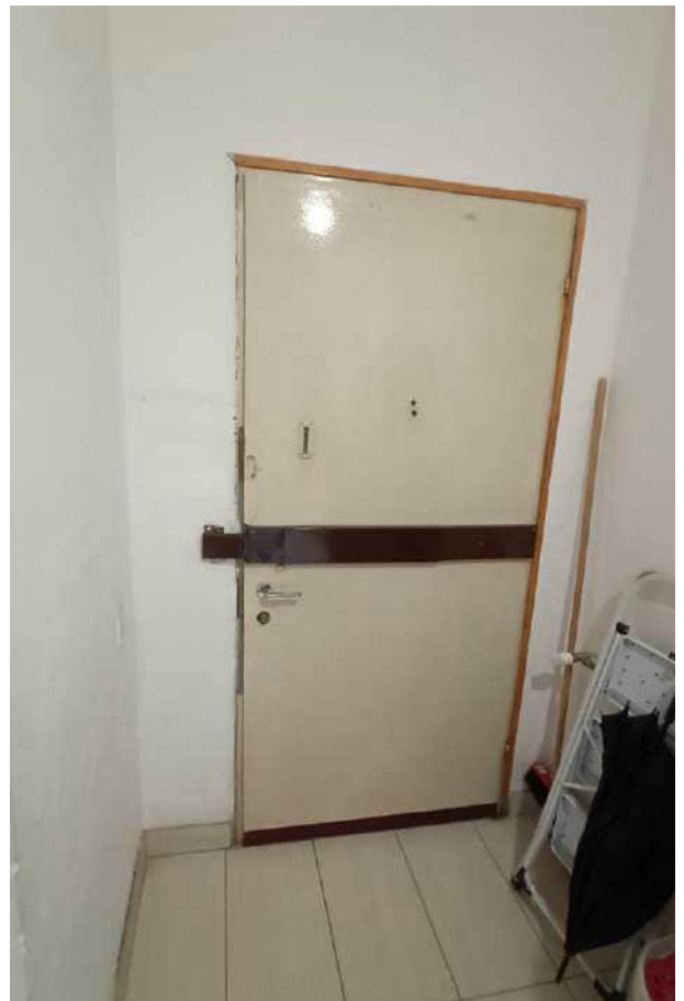
Foto 12 – Portoncino ingresso vista interna
