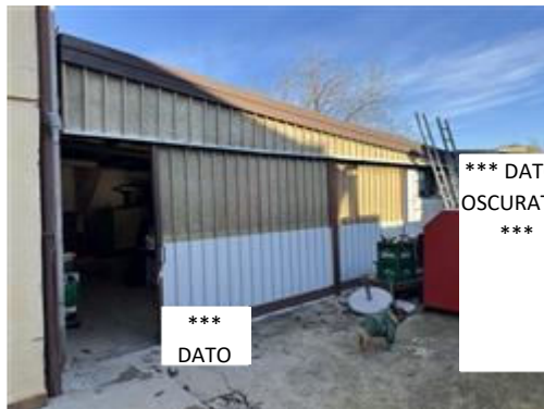
Capannone in ferro
