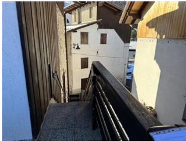
Scala di accesso al piano
