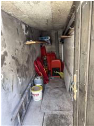
Vano servizi comune al piano terra
