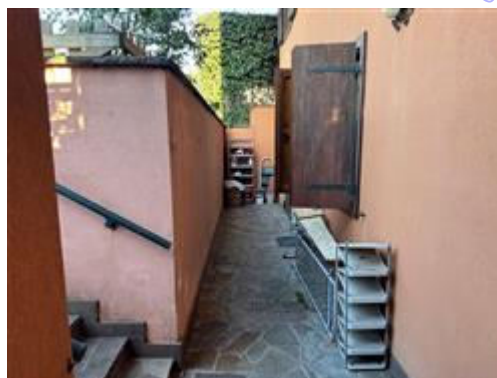
Accesso piano parzialmente interrato
