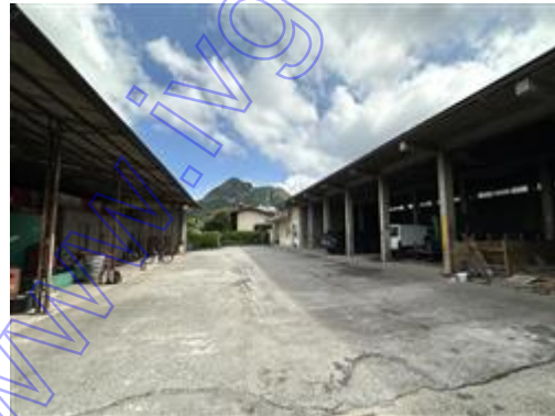
Veduta piazzale manovra
