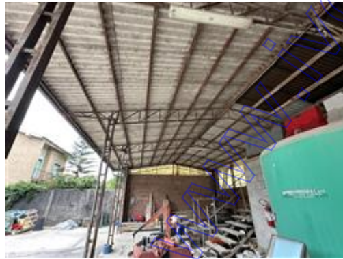
Veduta tettoia metallica
