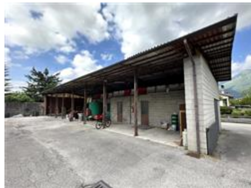
Particolare tettoia metallica
