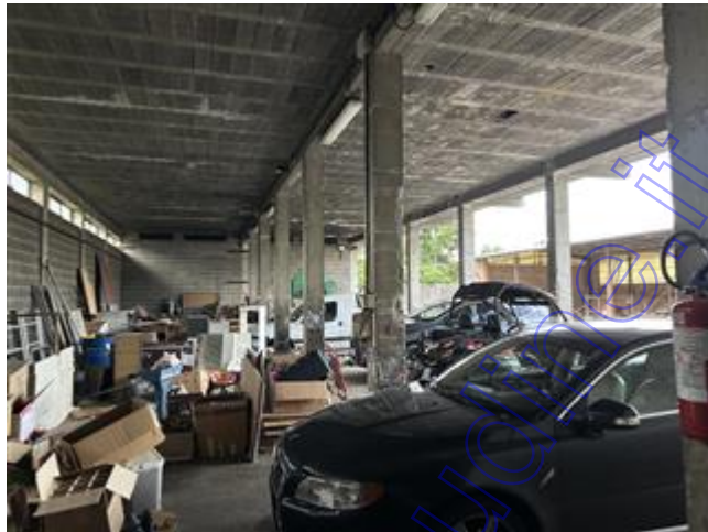
Veduta tettoia in c.a.
