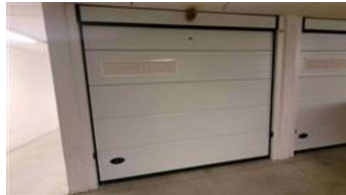
Garage oggetto del pignoramento
