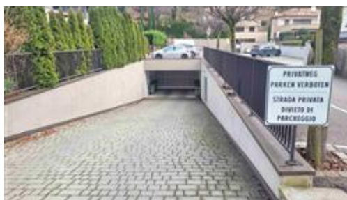
Rampa di accesso al piano interrato
