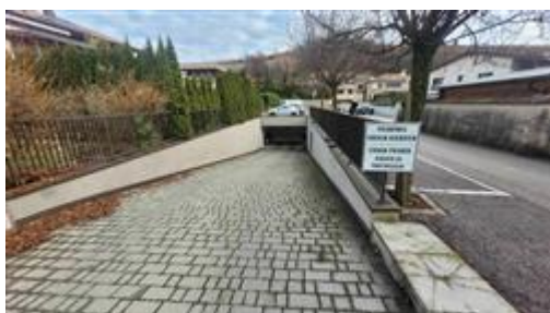
Rampa di accesso al piano interrato
