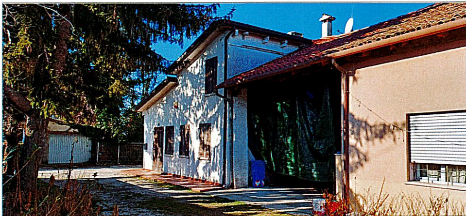
3 - Immagine dell'abitazione, del garage e dell'area di pertinenza dal cortile comune
