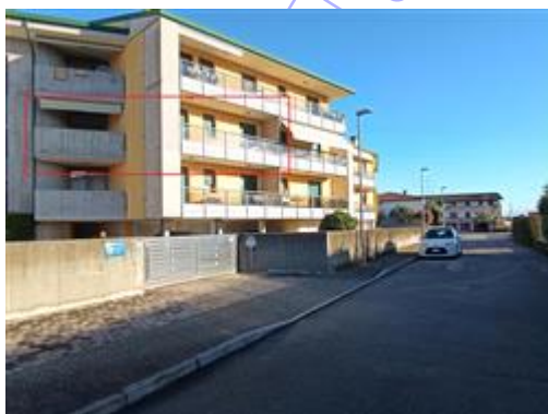
Vista Nord-Ovest Corpo A con l'accesso carrai e l'individuazione dell'unità pignorata
