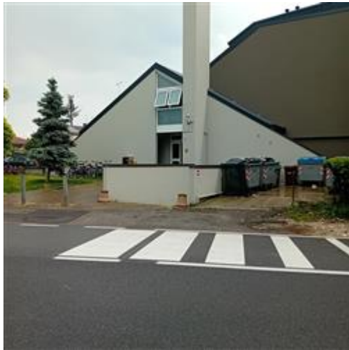
Vista prospetto lato Via San Rocco
