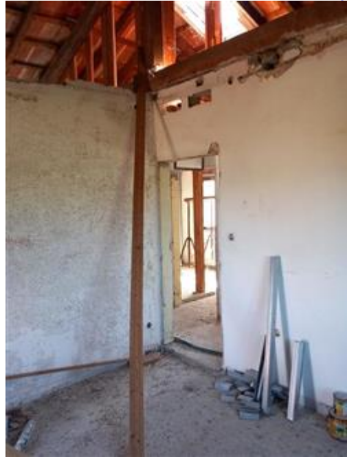
CONTROSSOFFITTO DEMOLITO
