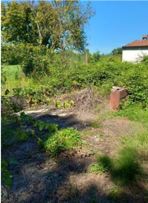
FABBRICATO ACCESSORIO PARZIALMENTE DEMOLITO
