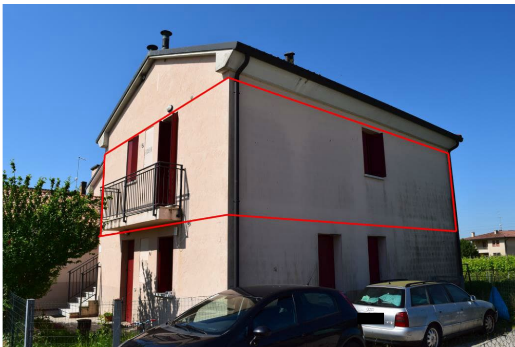
Foto 04: Identificazione appartamento lato nord e lato est
