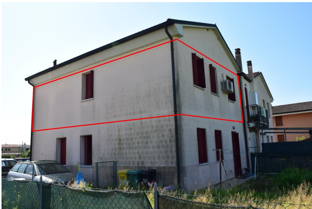
Foto 03: Identificazione appartamento lato nord e lato ovest
