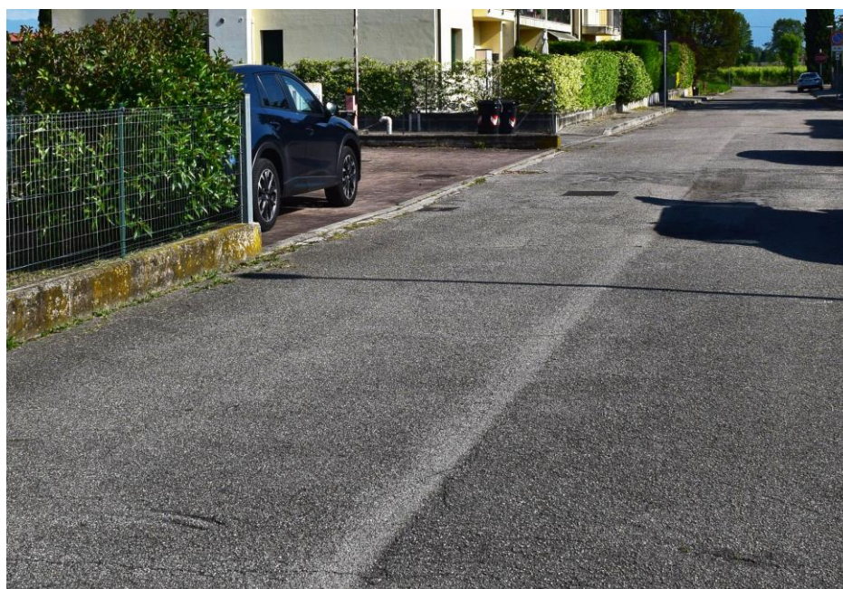
Foto 02: Vista accesso da Via Castelvechio
