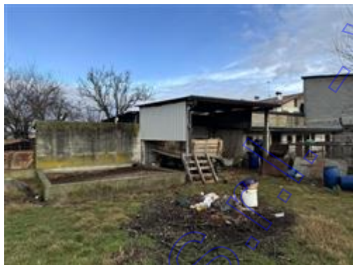
Tettoia abusiva vista Sud/Ovest
