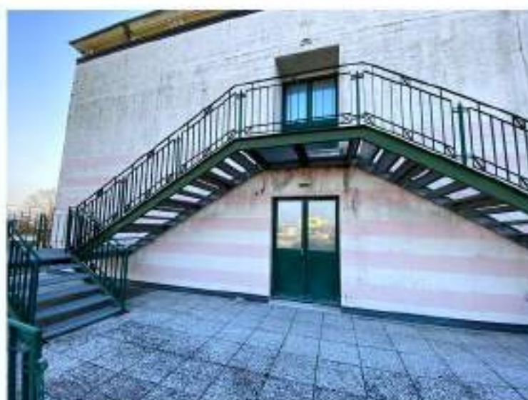
94_terrazza esterna con scale di emergenza
