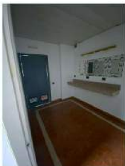
46_accesso ai servizi igienici ala Sud Ovest
