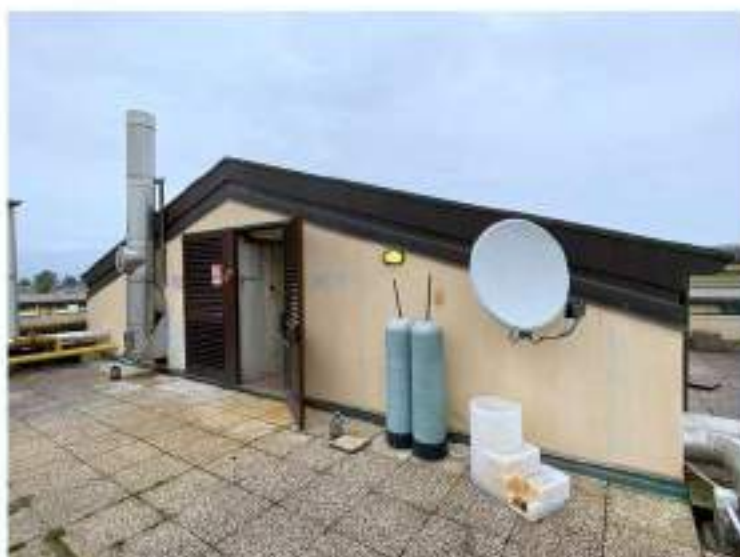
99_uscita terrazza verso lato Sud Ovest
