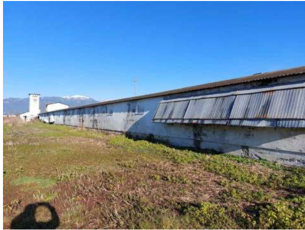
Edificio 1 lato ovest
