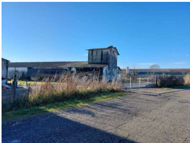
Ingresso da Via Brenton – Edificio 2
