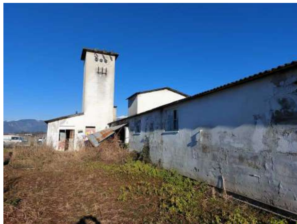
Cabina ENEL Edificio 1
