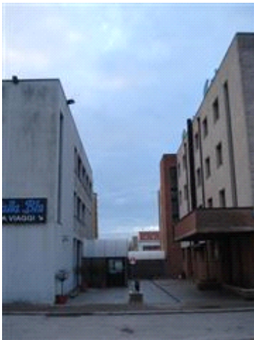
vista posteriore con tunnel collegamento edificio Meeting
