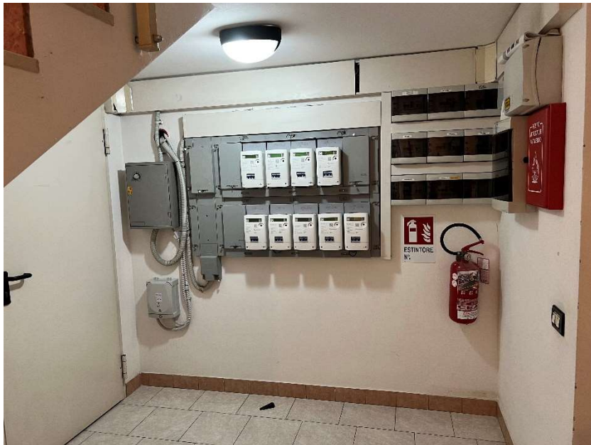
Vano contatori nel sotto scala
