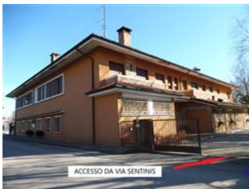
Accesso dalla strada pubblica, Via Sentinis
