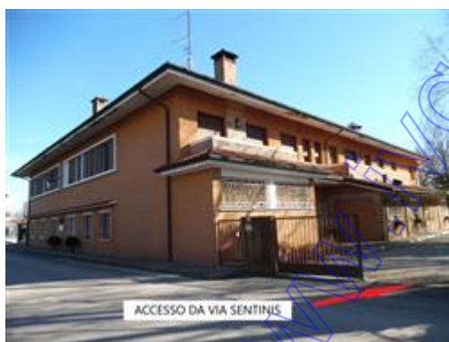
Accesso da Via Sentinis - Corpi A, B e C
