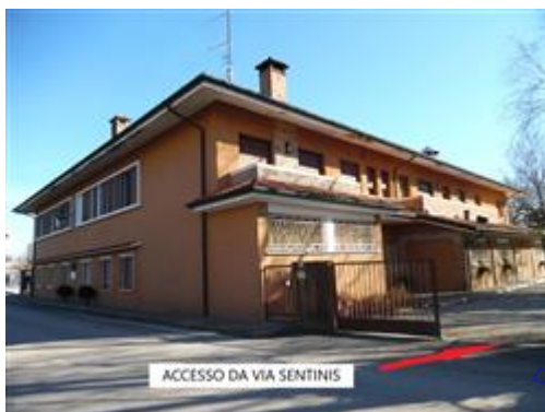
Accesso dalla strada pubblica, Via Sentinis
