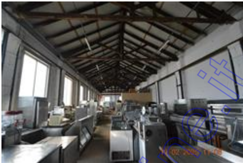
Dettaglio capannone in muratura e legno
