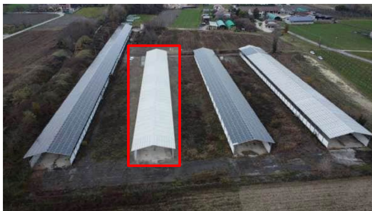
Foto D4: non risultano installati moduli fotovoltaici sulla copertura del fabbricato n.2.
