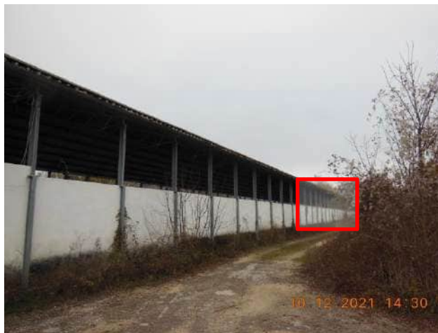
Foto C9: quadri di stringa posizione Nord fabbricato n.1.
