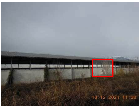
Foto E7: quadri di stringa posizione centrale e Sud fabbricato n.3.
