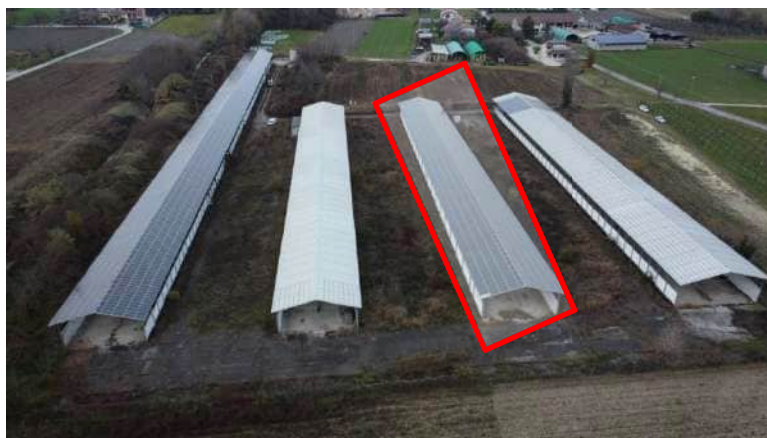
Foto E8: moduli fotovoltaici sulla copertura del fabbricato n.3.
