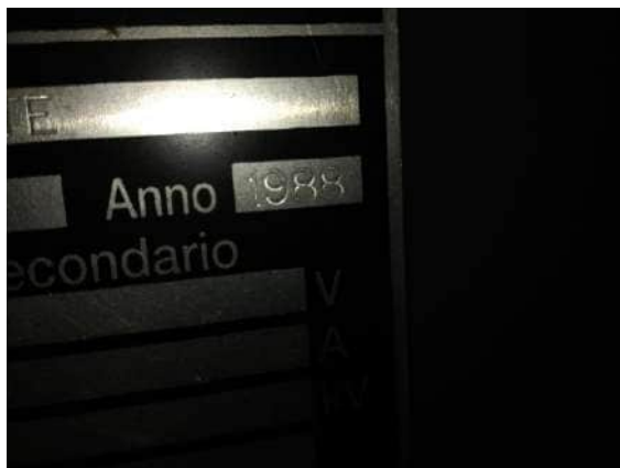
Foto B5: particolare anno di costruzione targa trasformatore trifase.
