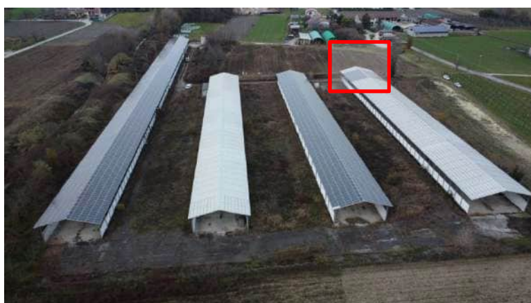
Foto F5: moduli fotovoltaici sulla copertura del fabbricato n.4.
