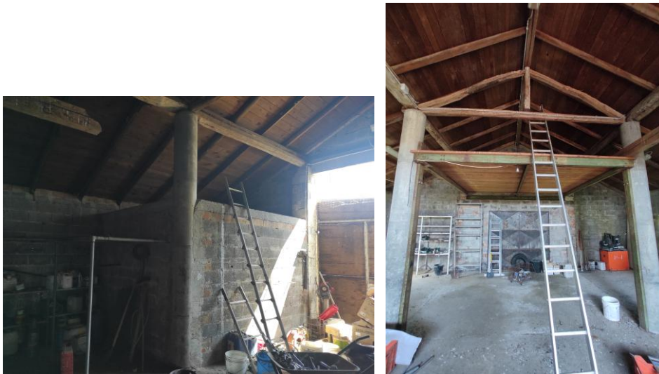
Vano interno e soppalco
