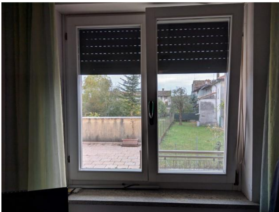
FOTO 27: PARTICOLARE SERRAMENTO LOCALI P.T.
