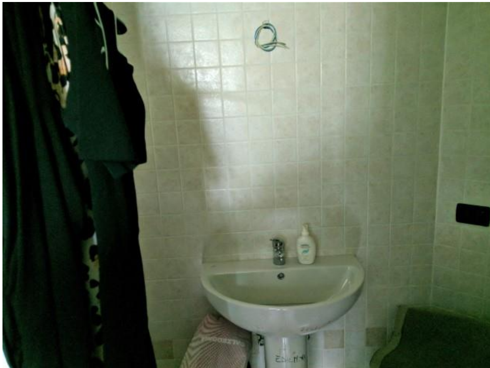
FOTO 21: WC DELLA CAMERA (Subalterno n. 1 – P.T.)
