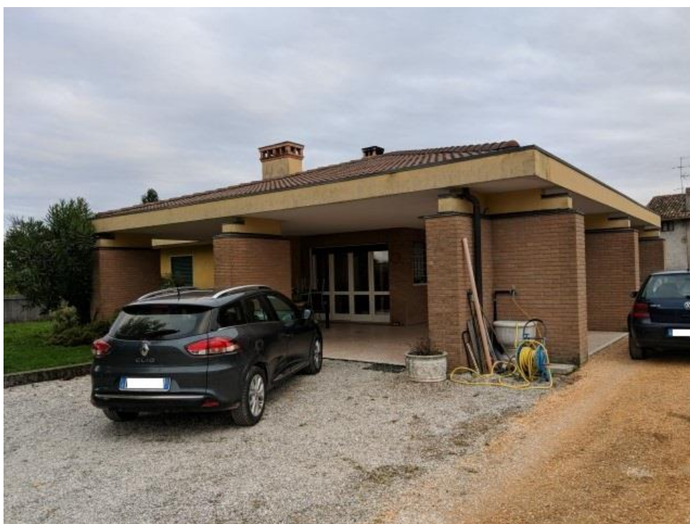
FOTO 12: PORTICATO D'INGRESSO AL PIANO TERRA
