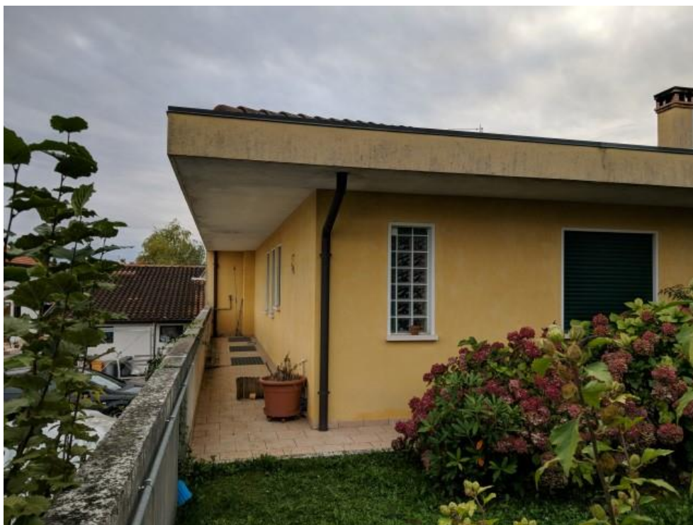
FOTO 11: ALTRA PANORAMICA DELL'IMMOBILE
