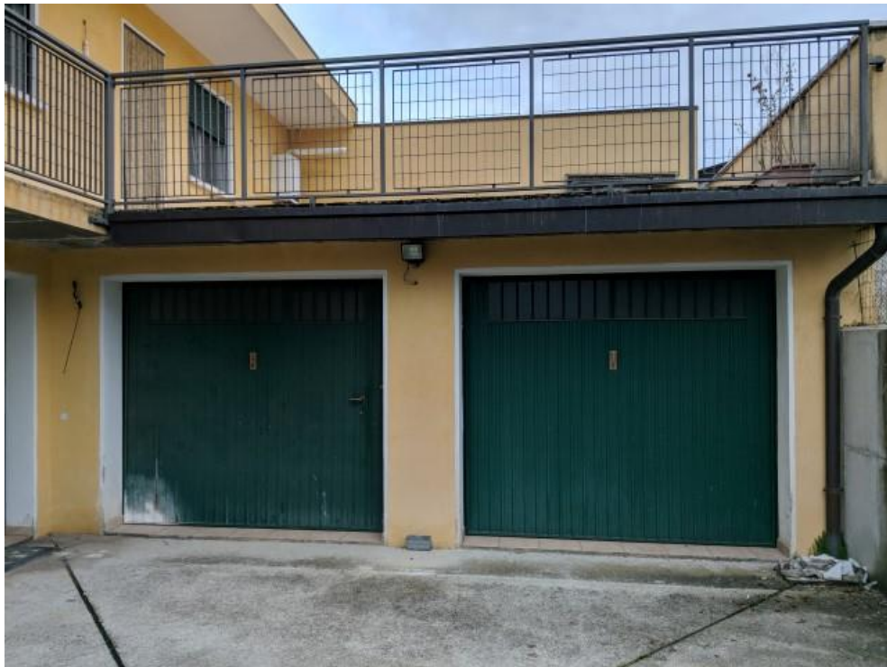
FOTO 45: ACCESSI DELLA TETTOIA DAL PIAZZALE AL P.INT.
