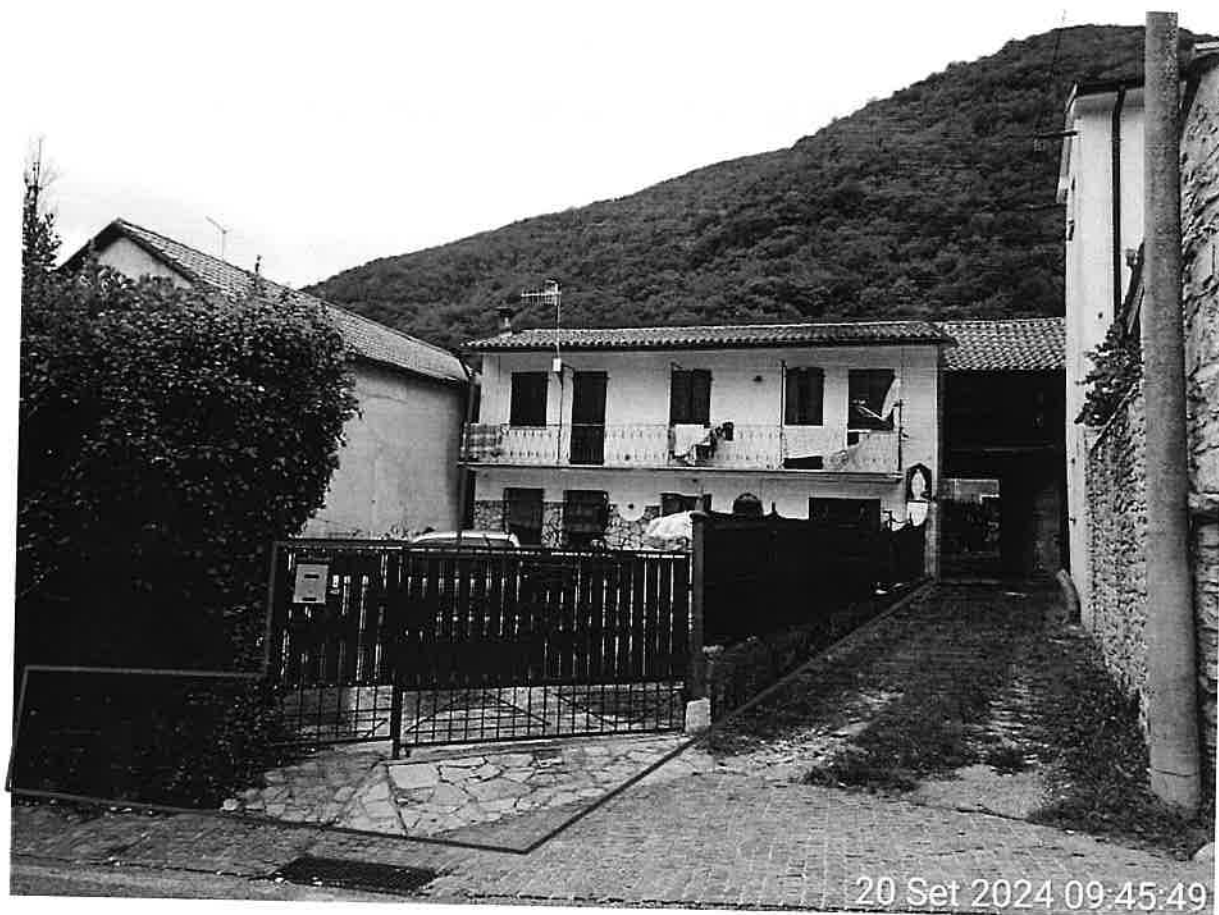
Vista da est – Accesso carrabile e pedonale da via Santa Maria
