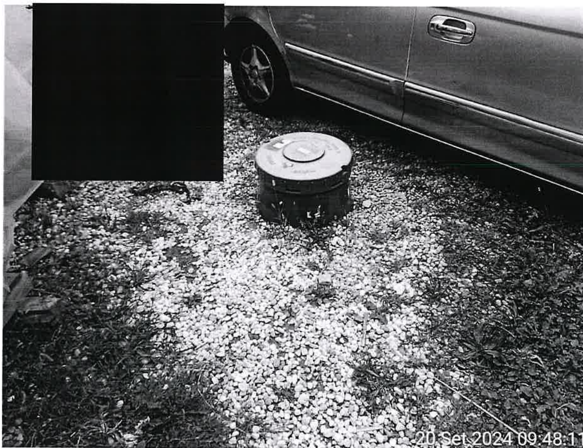
Presenza serbatoio gpl all'interno dell'area di pertinenza
