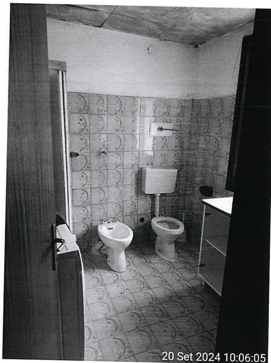
Bagno piano primo
