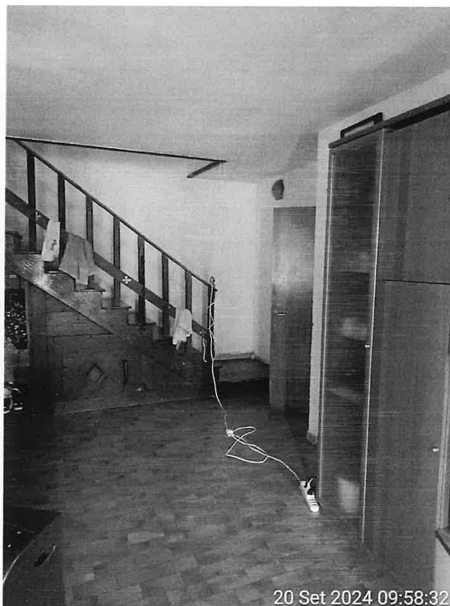
Ingresso a piano terra e vista scala che porta al piano primo
