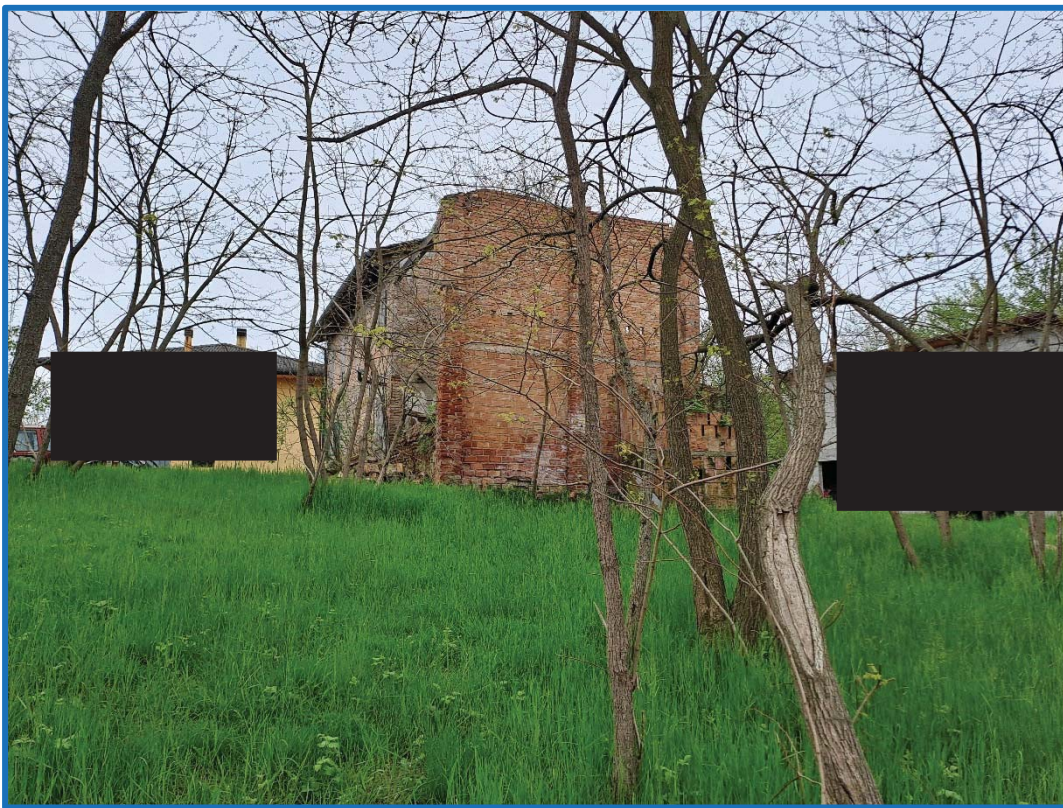
n° 5 – Esterno OVEST
