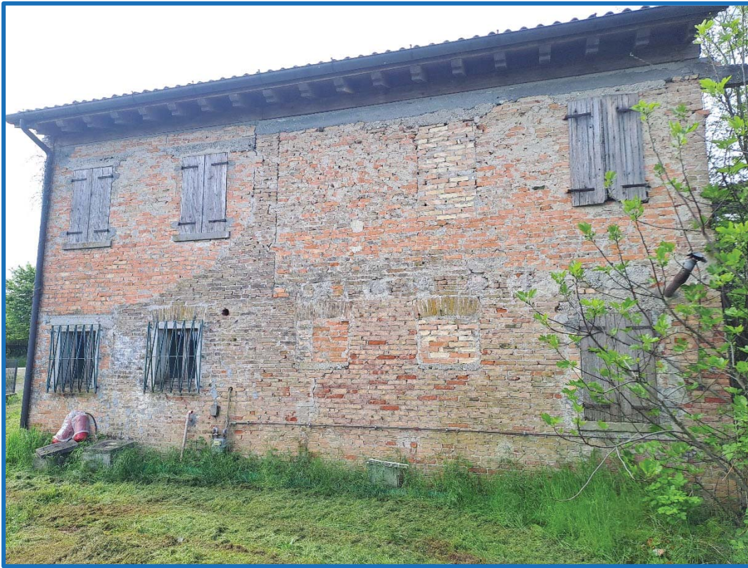
n° 3 – Esterno NORD
