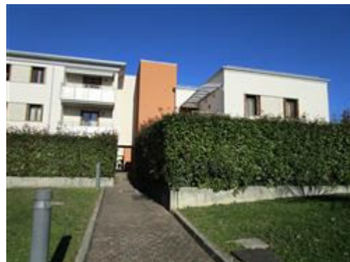
Vista complesso residenziale - accesso pedonale da via Cividale
