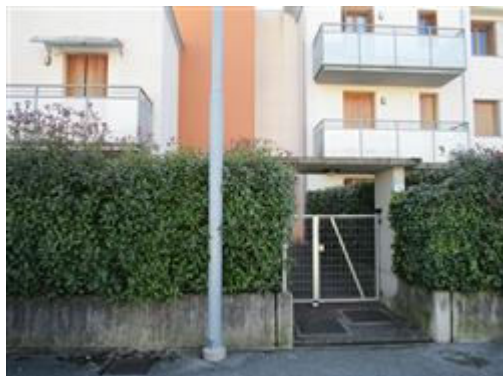
Vista ingresso da via Fella
