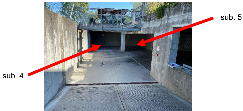
vista interna posti auto coperti oggetto di esecuzione immobiliare (sub. 4 e sub. 5)
