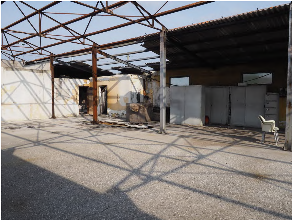
Caorle, strada Riello n. 2 – L'interno del capannone.
