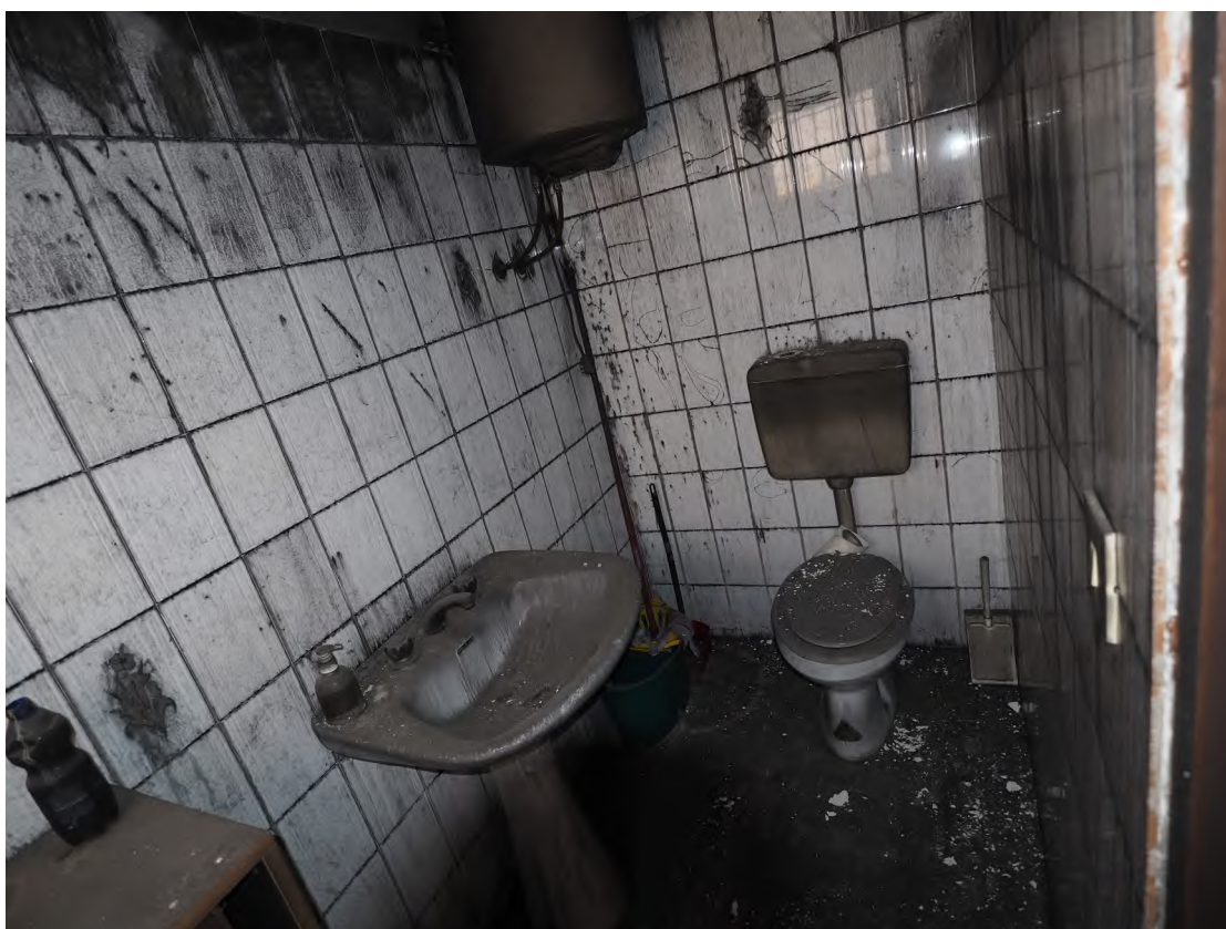
Caorle, strada Riello n. 2 - Il locale wc .
