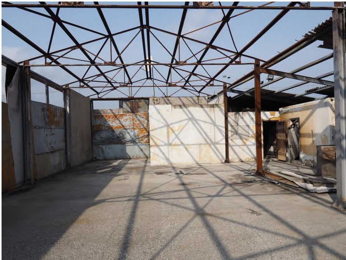
Caorle, strada Riello n. 2 – L'interno del capannone.
