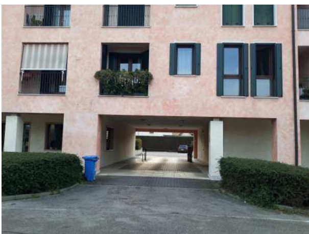
Foto 5 – portale accesso carrabile ad area interna
