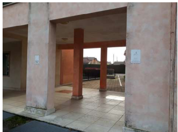
Foto 4 – portale accesso pedonale ad area interna
