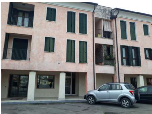
Foto 13 – ingresso vano scale
