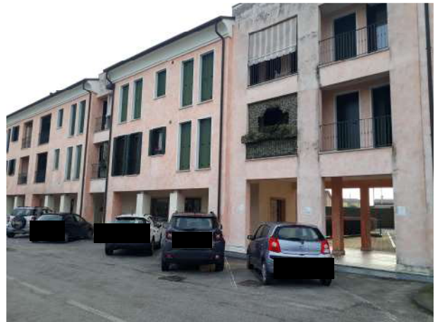
Foto 2 – prospetto ovest (ingresso)
