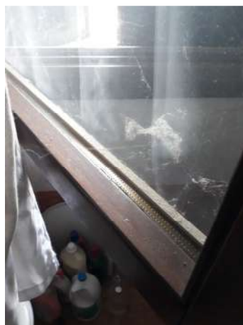
Foto 20 – particolare infissi esterni
