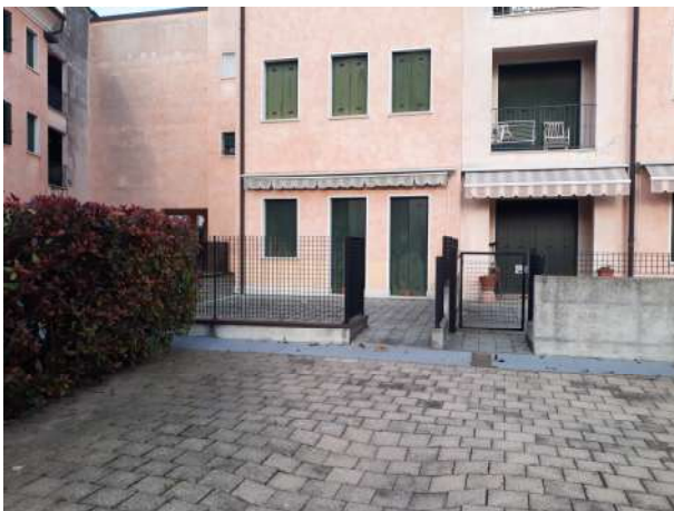
Foto 9 – accesso pedonale da area comune
