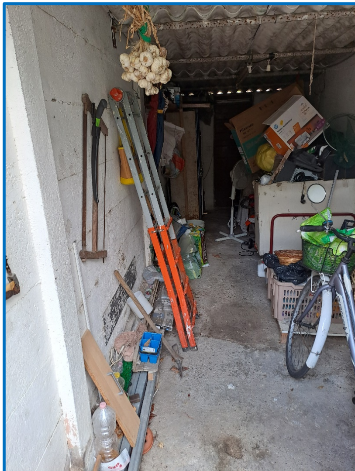
n° 8 - Interni tettoia
