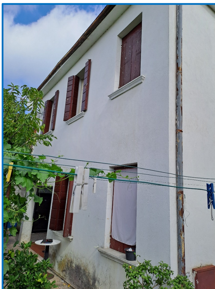
n° 2- Esterno da sud
