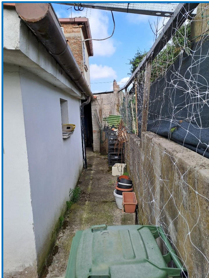
n° 10 – Esterno lato nord
