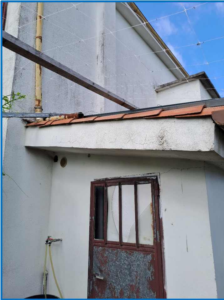
n° 9 – Esterno centrale termica
