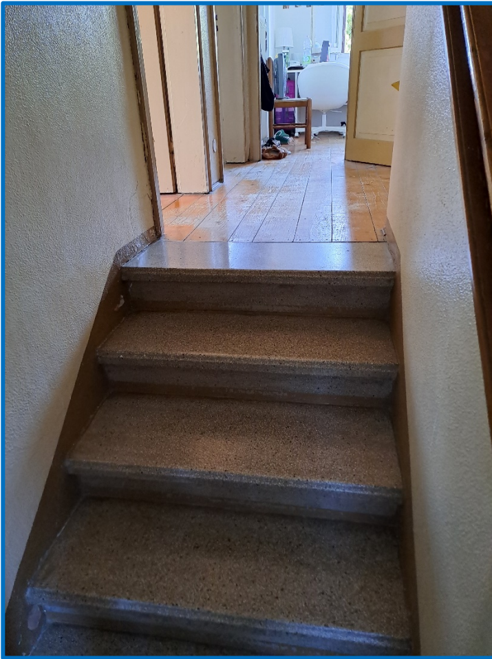
n° 11 – Interni piano ammezzato
