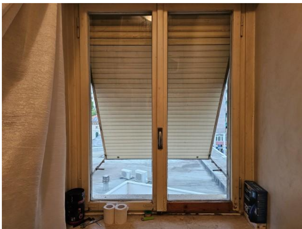
FOTO 18: SERRAMENTO (SUB. 32 – 4°P.)
