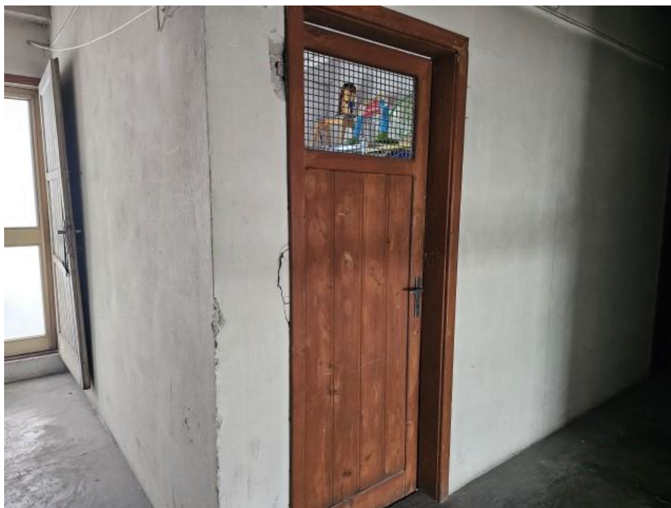
FOTO 21: SOFFITTA (SUB. 32 – 7°P.)
