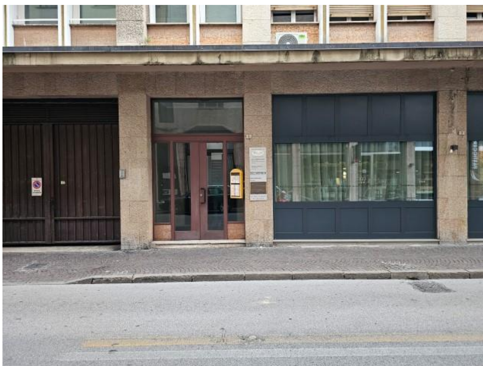
FOTO 4: ACCESSO VANO SCALE CONDOMINIALE SU VIALE COSSETTI
