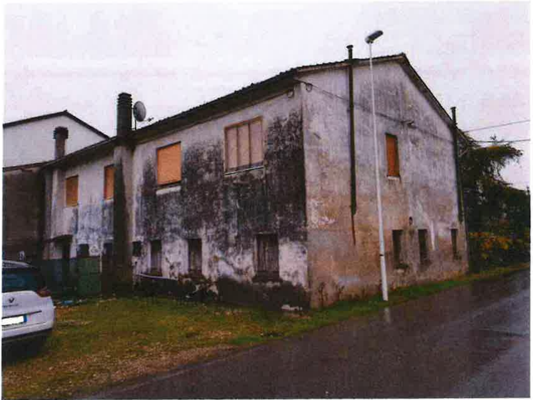
Vista nord-ovest fabbricato
