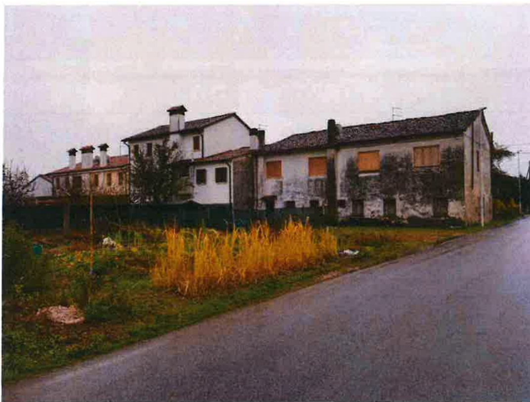
Vista nord-ovest fabbricato e terreno (mappale n. 983)
