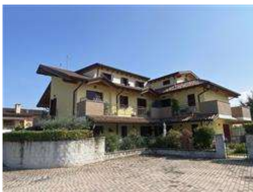
Vista dal cortile interno
