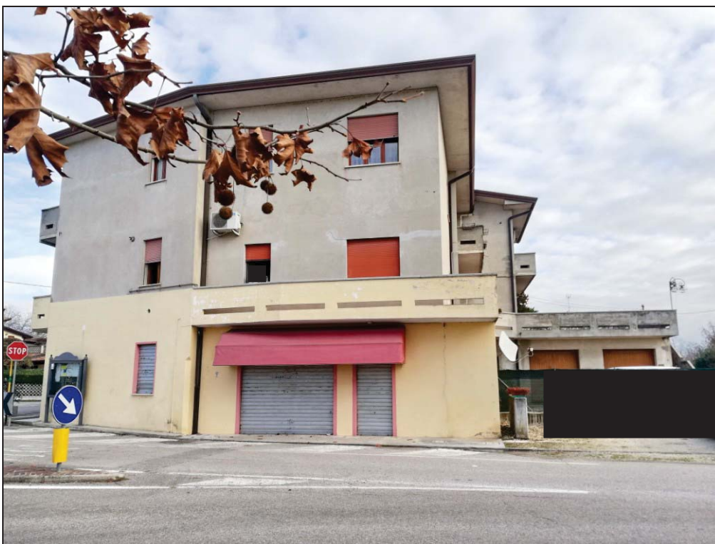
Foto 02 – Fronte ovest da via Zoncè
