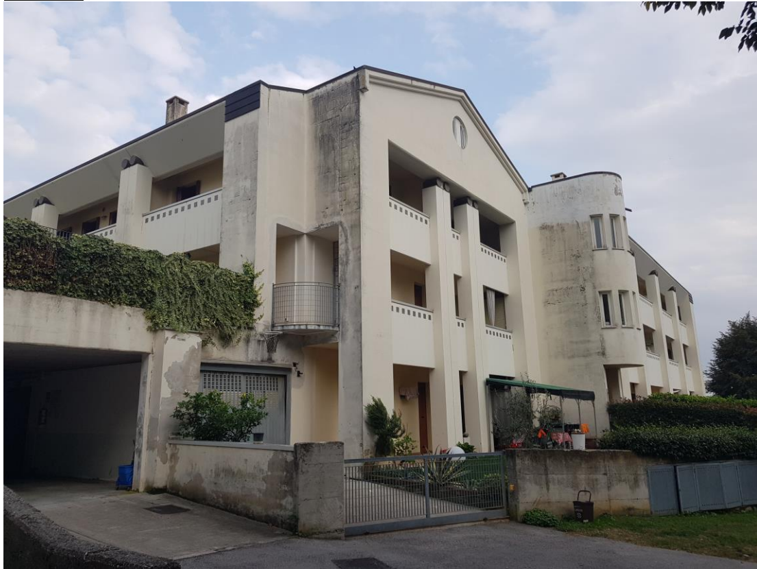
VISTA ESTERNA - FACCIATA NORD/OVEST
