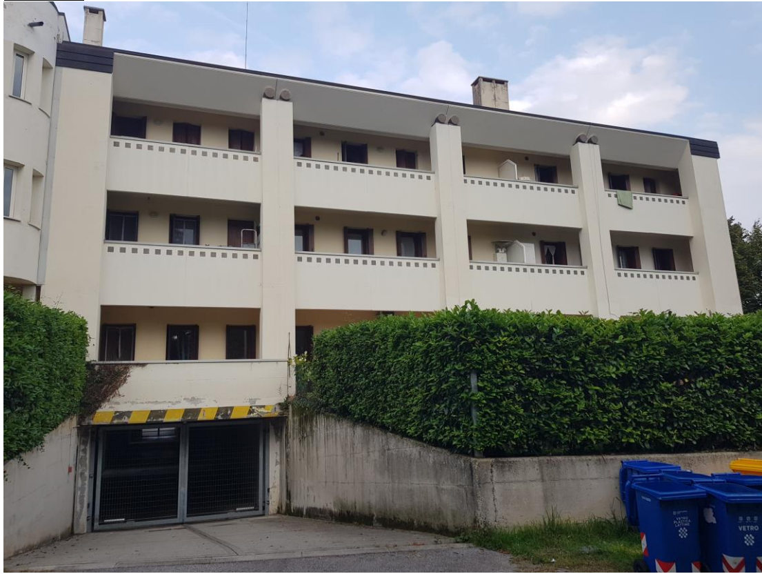
VISTA ESTERNA - FACCIATA SUD/OVEST
