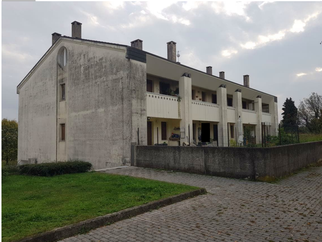
VISTA ESTERNA - FACCIATA NORD/EST
