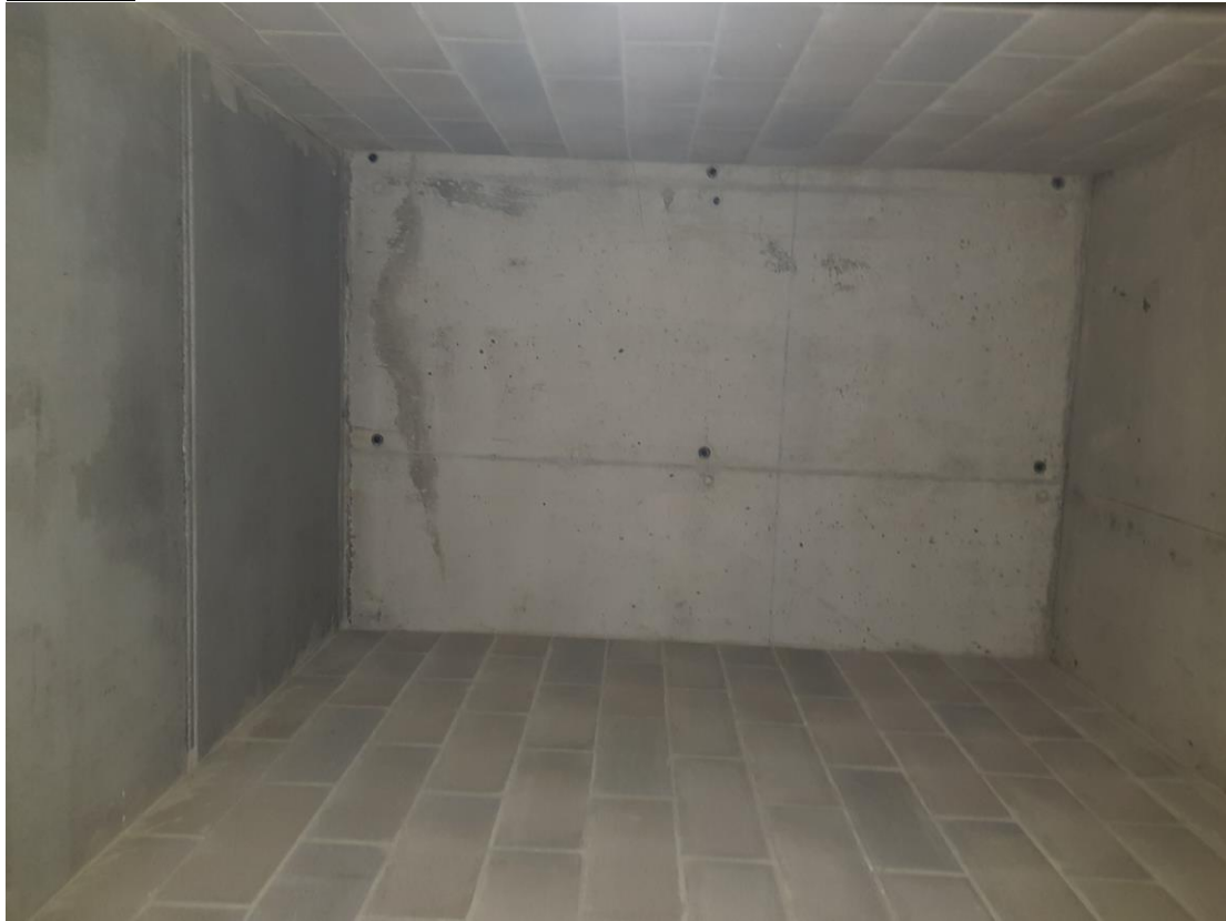
VISTA INTERNA - PIANO INTERRATO - RIPOSTIGLIO
