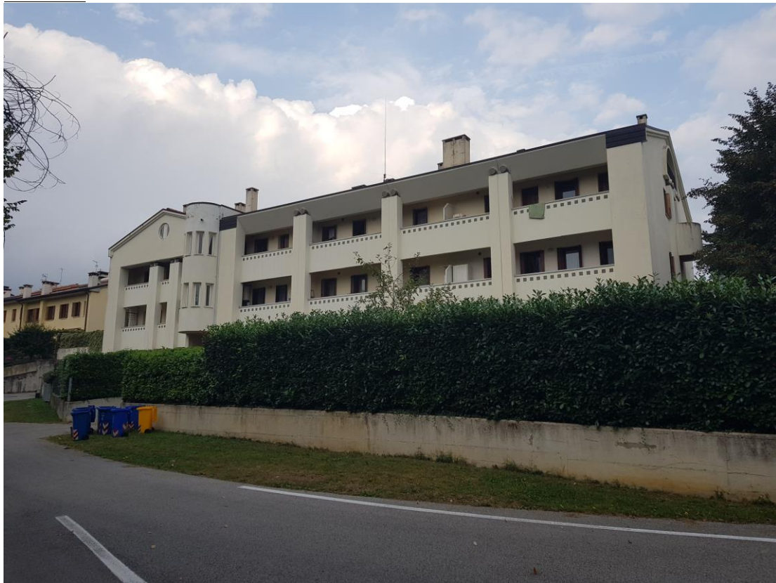
VISTA ESTERNA - FACCIATA SUD/OVEST
