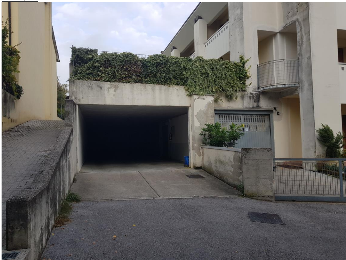
VISTA ESTERNA - FACCIATA SUD/OVEST
