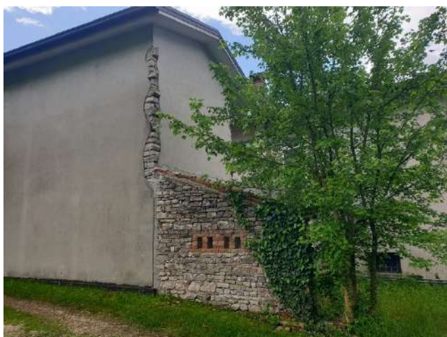
foto n. 15 – area scoperta nord
