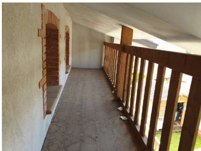
foto n. 13 – terrazza al P2
