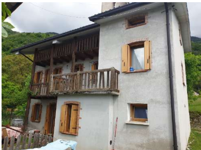
foto n. 1 – fronte sud dell'abitazione
