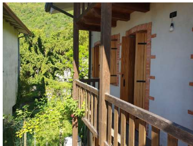
foto n. 12 – terrazza al P1
