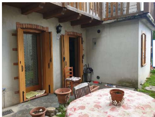
foto n. 14 – area scoperta sud-entrata abitazione
