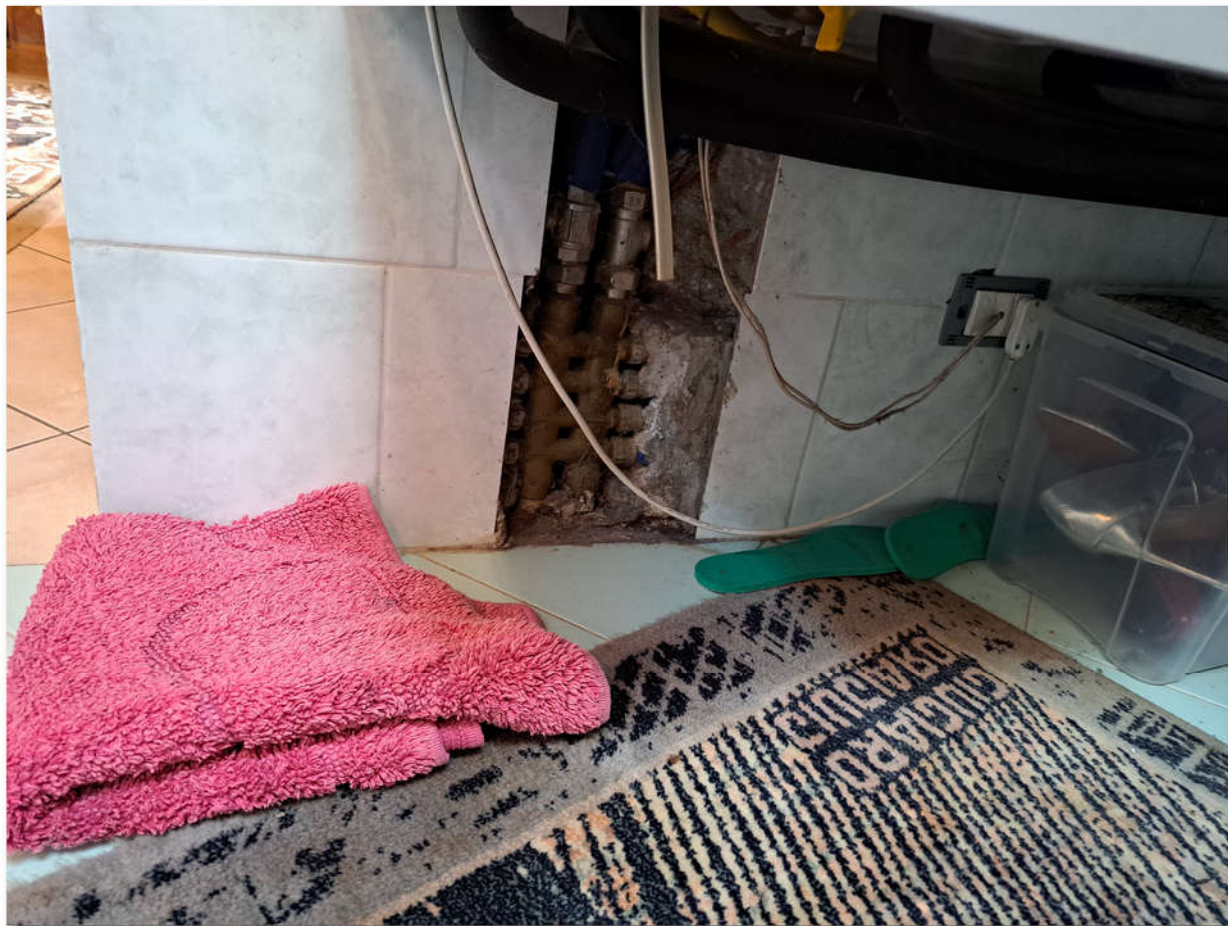
29_collettore riscaldamento
