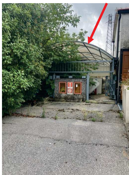
ulteriore particolare della tettoia abusiva lato Nord
