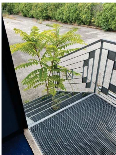
vista scala uscita di emergenza lato Ovest
