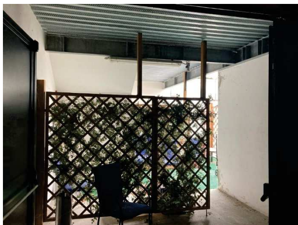
vista corte coperta dal piano rialzato
