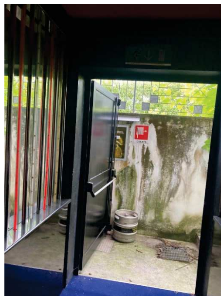
vista uscita di emergenza lato Ovest
