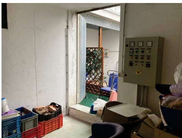
particolare interno ripostiglio comune
