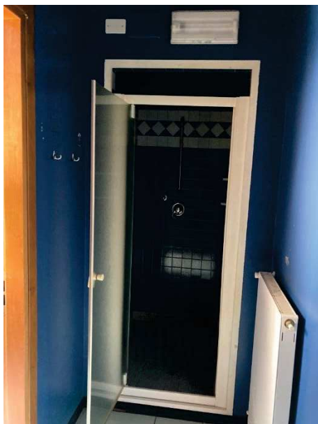
vista doccia e antibagno
