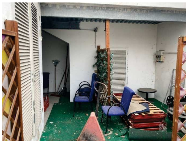
particolare ingresso magazzino sub. 14
