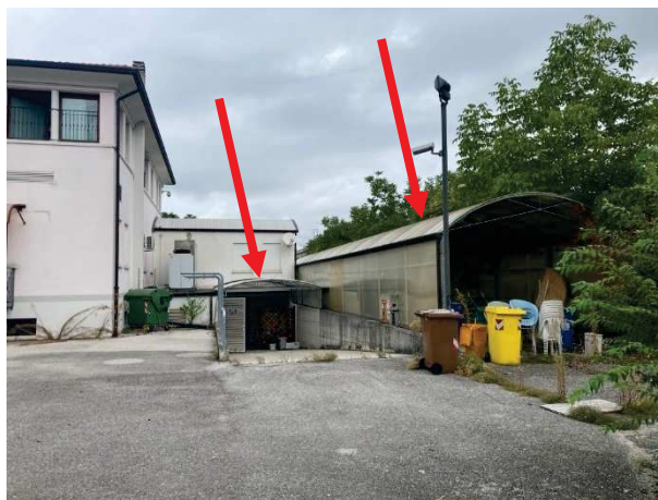
particolare delle due tettoie abusive lato Sud
