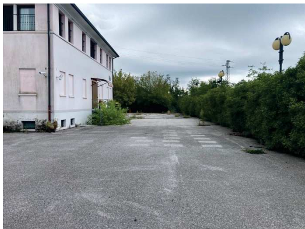
vista cortile interno
