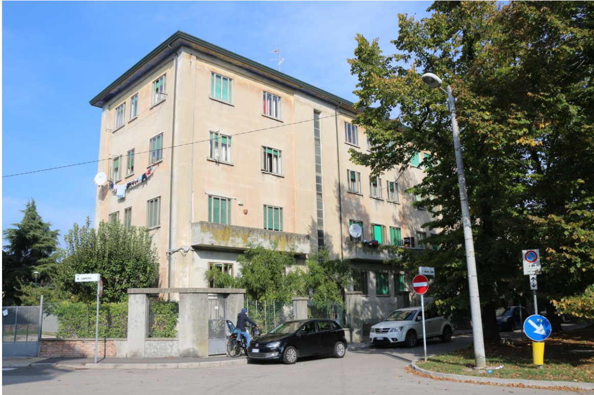
FOTO N°1. - visione esterna fabbricato
