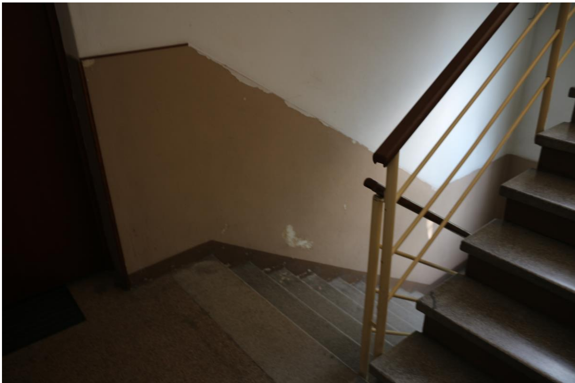
FOTO N°4. - visione vano scale condominiale
