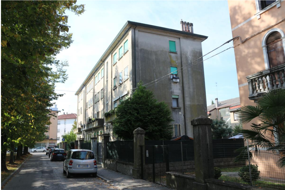
FOTO N°3. - visione esterna fabbricato
