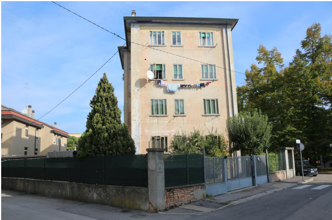
FOTO N°2. - visione esterna fabbricato
