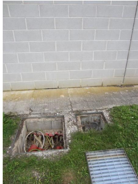
Infine, dal quadro elettrico generale dipartono poi le linee secondarie interrato di alimentazione locali dell'hangar con uffici e ristorante con piscina, la cui evidenza
