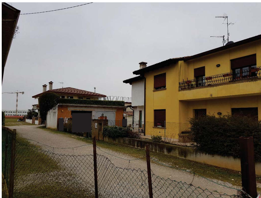
FOTO 4 – FABBRICATO E CORTILE CON AUTORIMESSA
