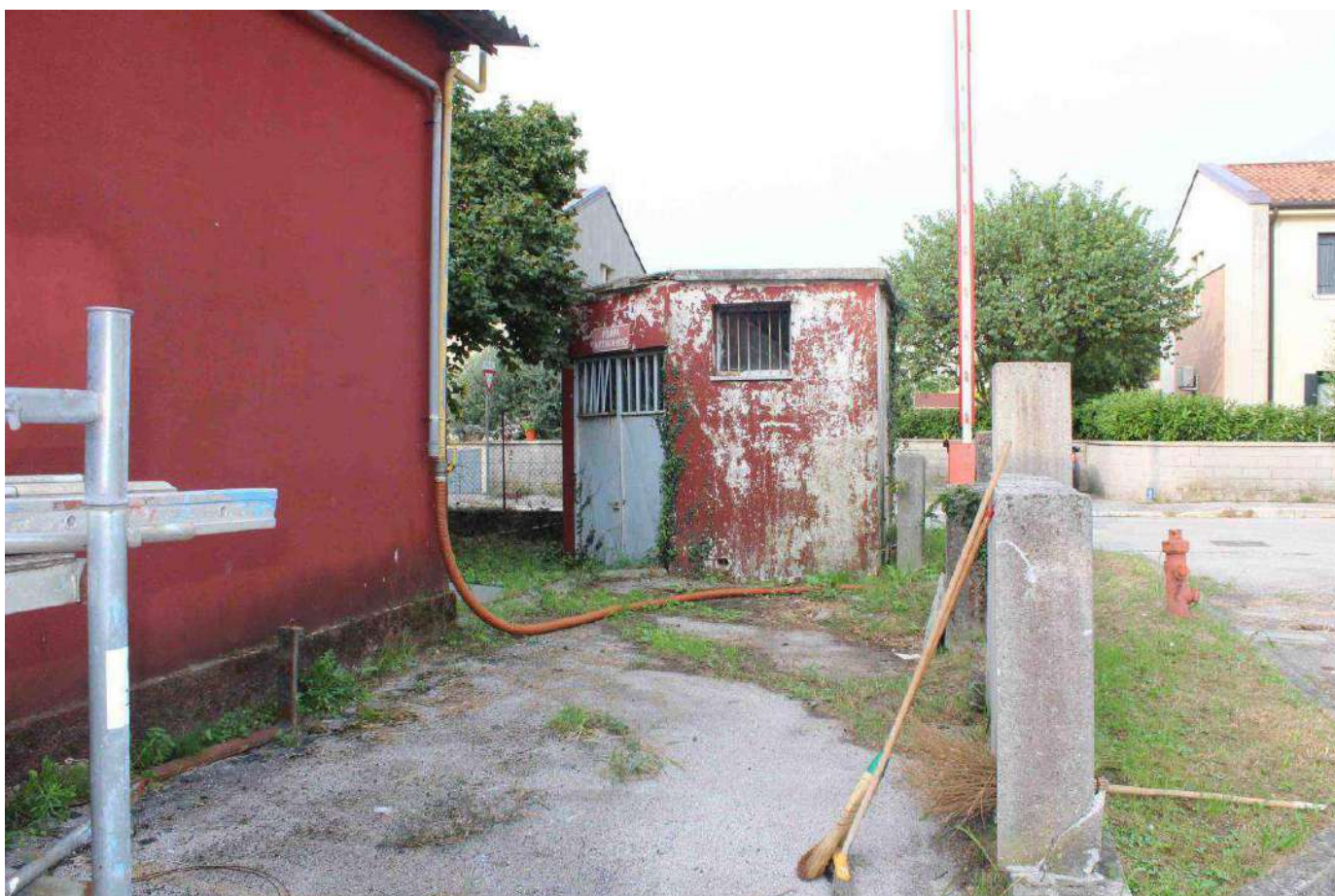
mapp. 138: esterni, lato nord e cabina antincendio
