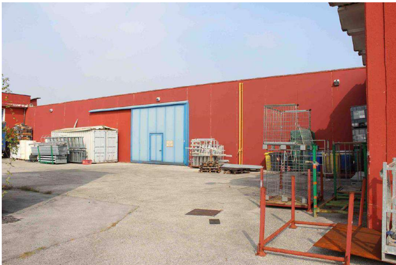
mapp. 138: esterni, lato sud
