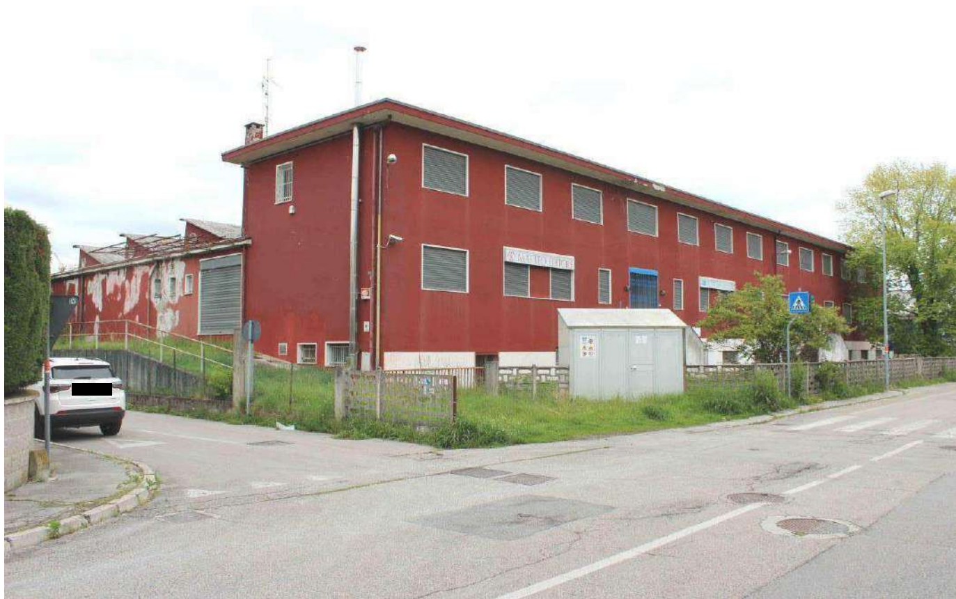
mapp. 138: esterni, facciata sud ed ovest su via Mattei
