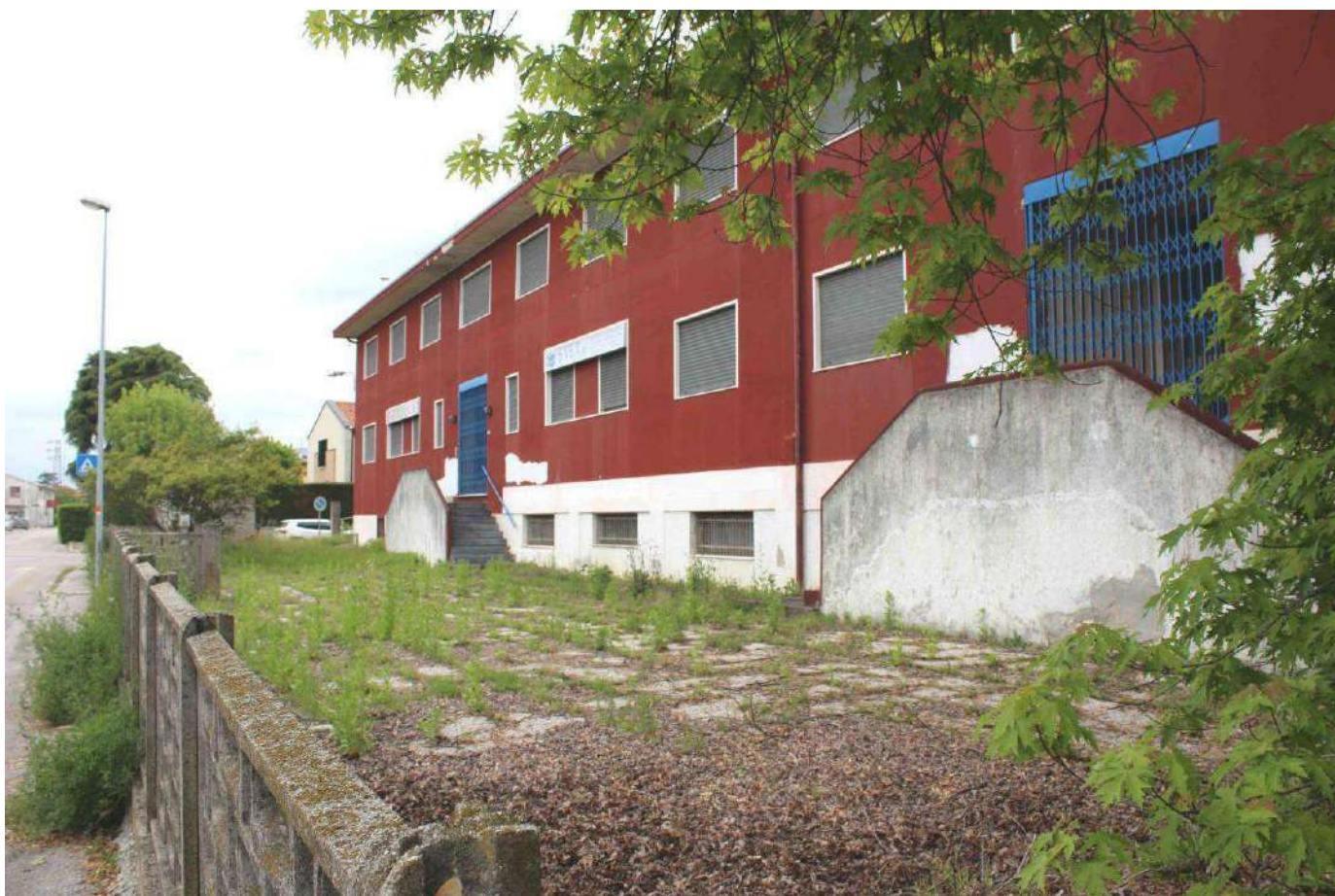
' mapp. 138: esterni, facciata sud su via Mattei
