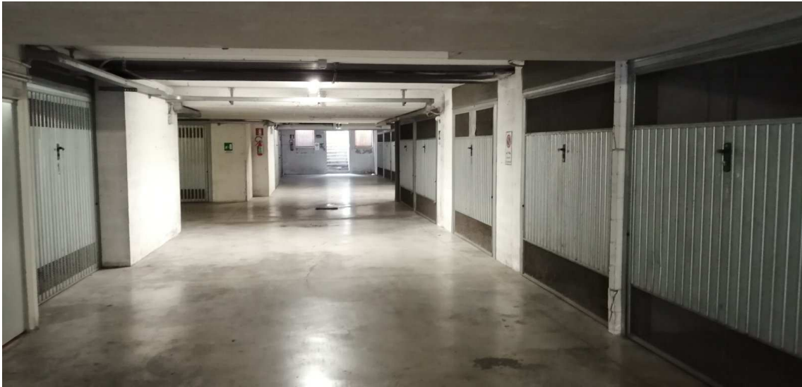
Corsia comune garage
