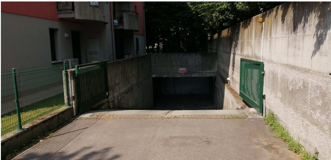
Rampa di accesso garage
