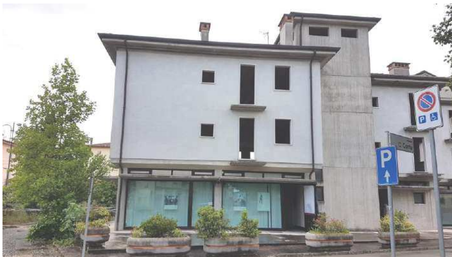
FOTO 7 : vista prospetto esterno lato est
