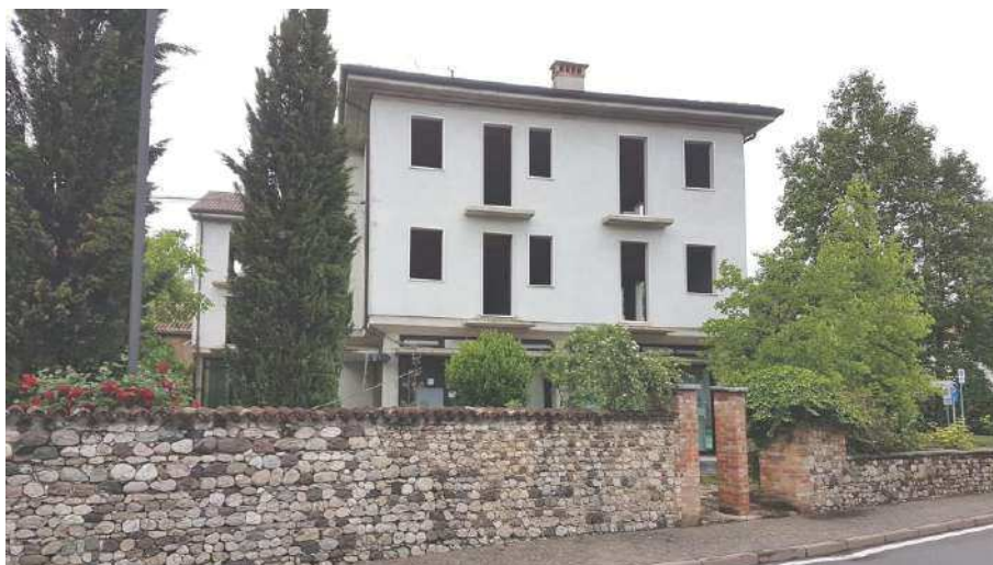
FOTO 8 : vista prospetto esterno lato sud
