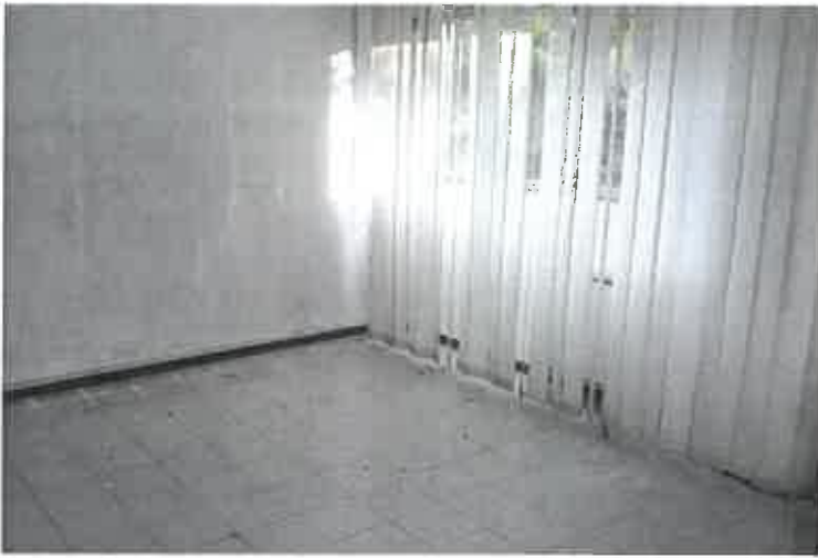
Zona uffici dei magazzini piano terra sub. 3
