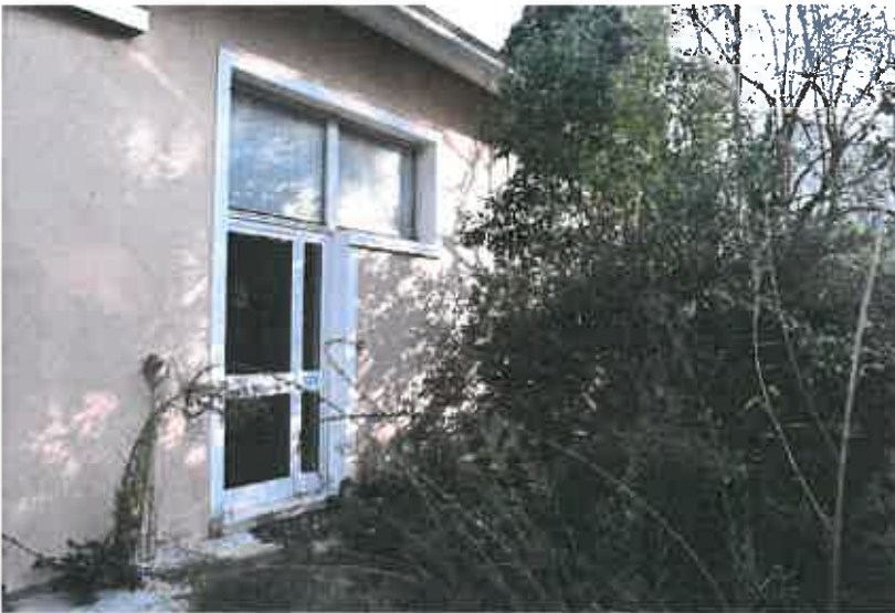
Vista con ingresso agli uffici del vecchio fabbricato
