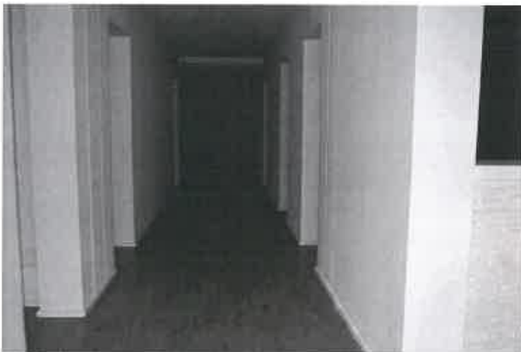
Uffici piano terra sub. 3 corridoio
