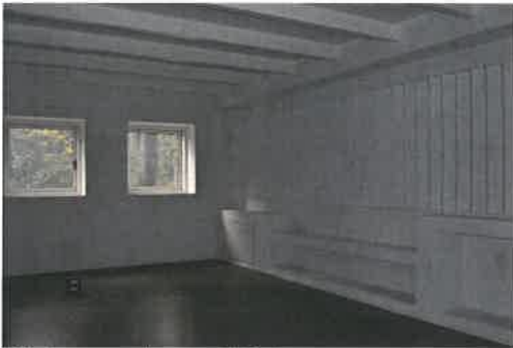
Uffici zona centrale ovest sub. 3 piano terra
