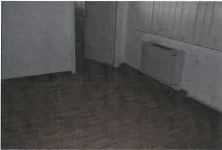
Zona uffici dei magazzini piano terra sub. 3
