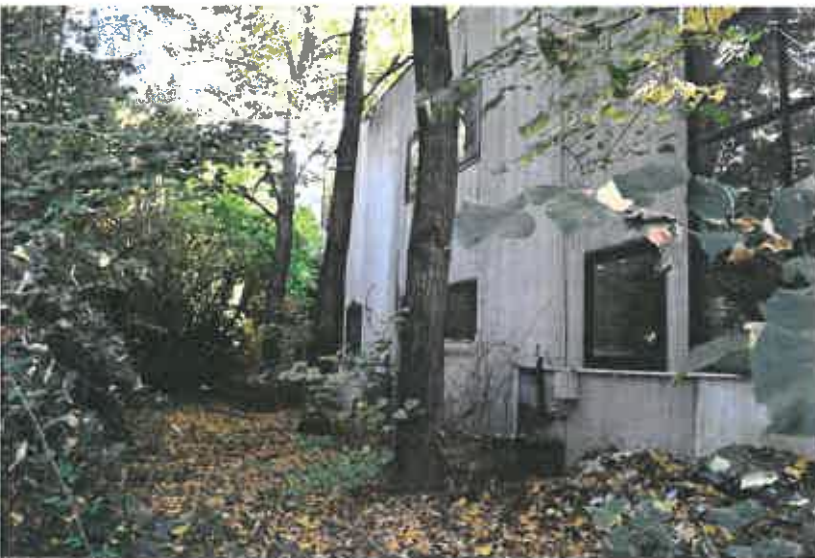
Vista nella parte ovest fronte Via D'Azeglio
