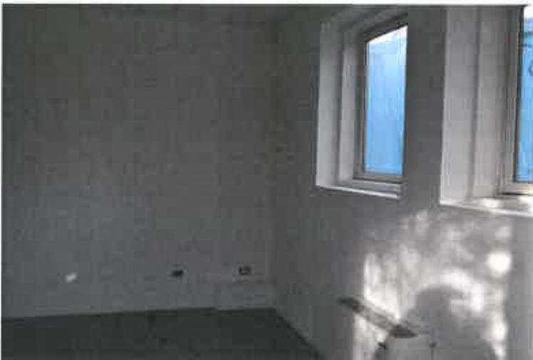
Vista interna sub. 3
