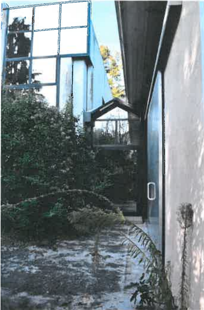
Ingresso autonomo al sub. 4
