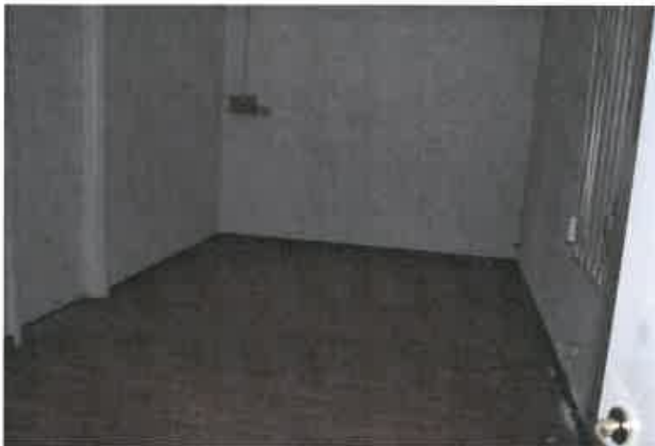
Zona uffici dei magazzini piano terra sub. 3
