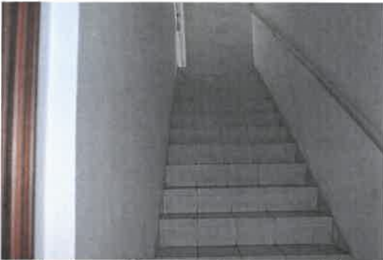
Scale che collegano uffici zona magazzino piano terra sub. 3
