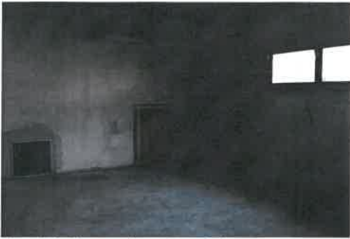
Magazzini vicino centrale termica sub. 3
