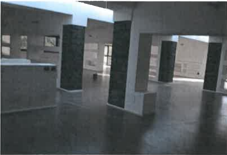
Interno sub. 4 parte centrale
