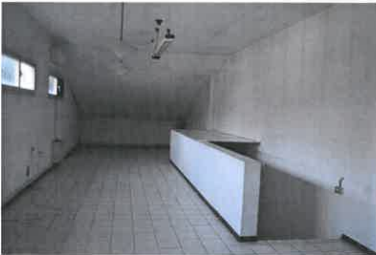
Zona uffici piano primo sub. 3
