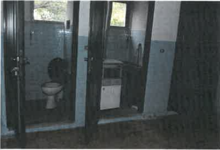
Bagni zona retro magazzini piano terra sub. 3
