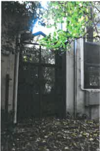
Vista nella parte ovest fronte Via D'Azeglio filtro tra la parte nuovo e vecchio fabbricato
