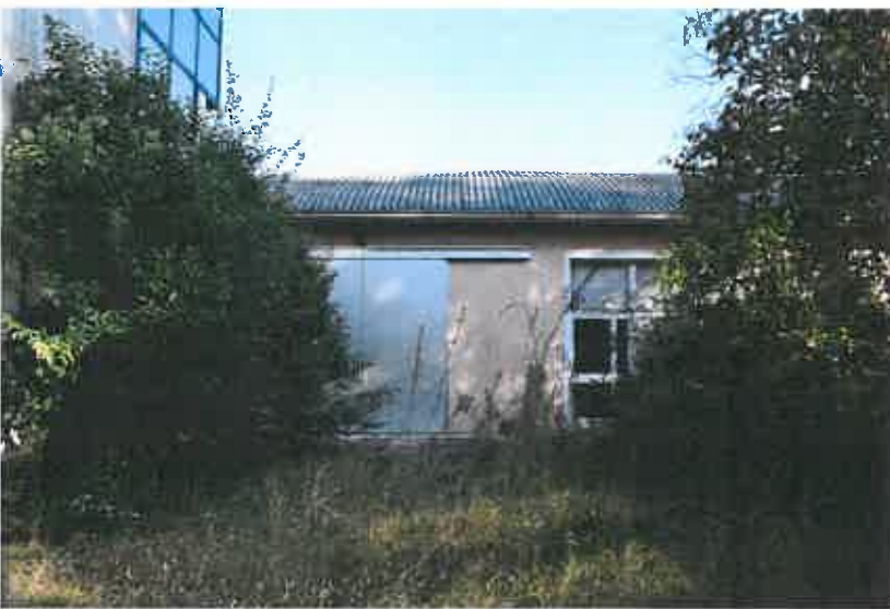
Ingresso dal portone ai magazzini
