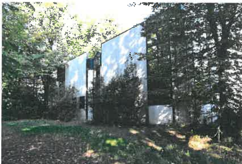
La facciata principale zona uffici vista sud
