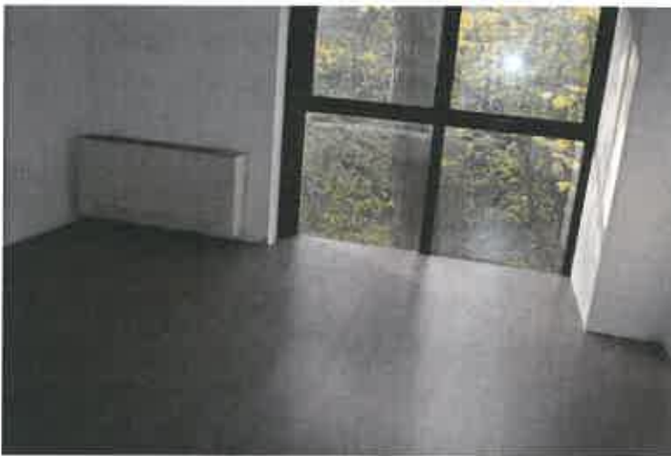
Sub. 4 zona nord-ovest
