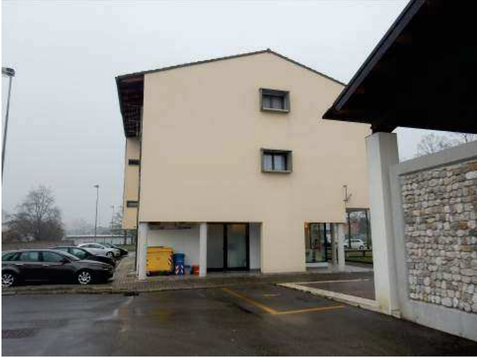
Foto 5-6: Fabbricato condominiale lato Sud e app.to lato Nord-Ovest.
