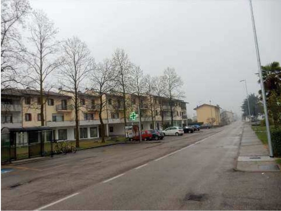
Foto 1-2: Fabbricato condominiale lato Ovest.
