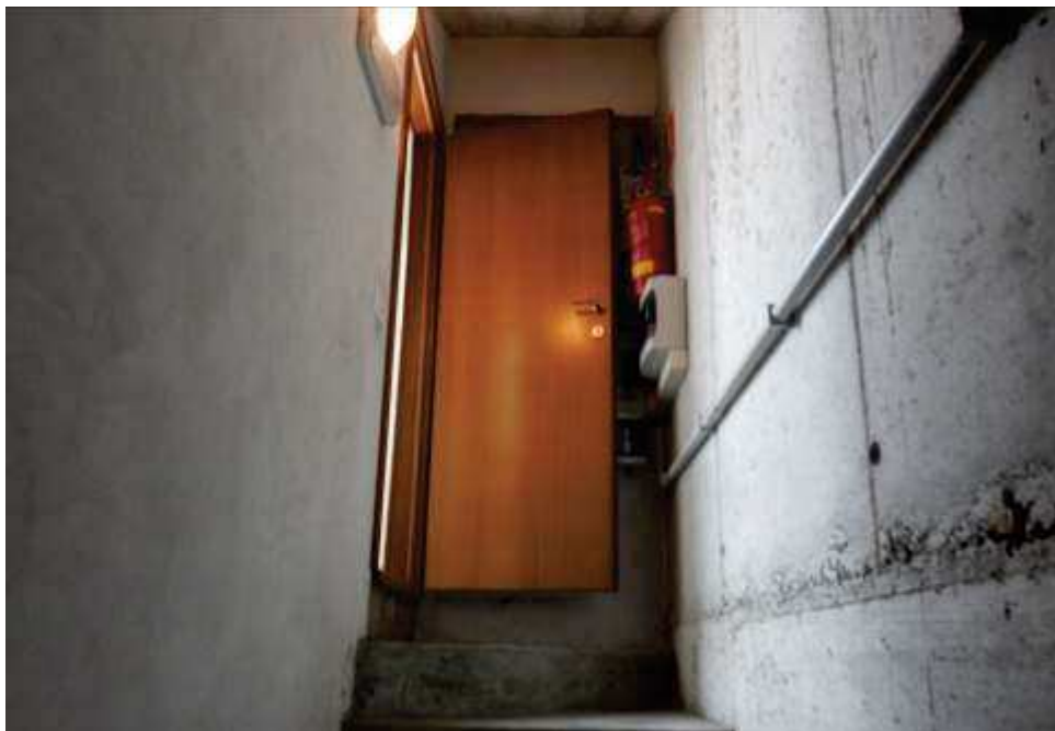
Foto 29-30: Vano scale interrato e piano secondo.
