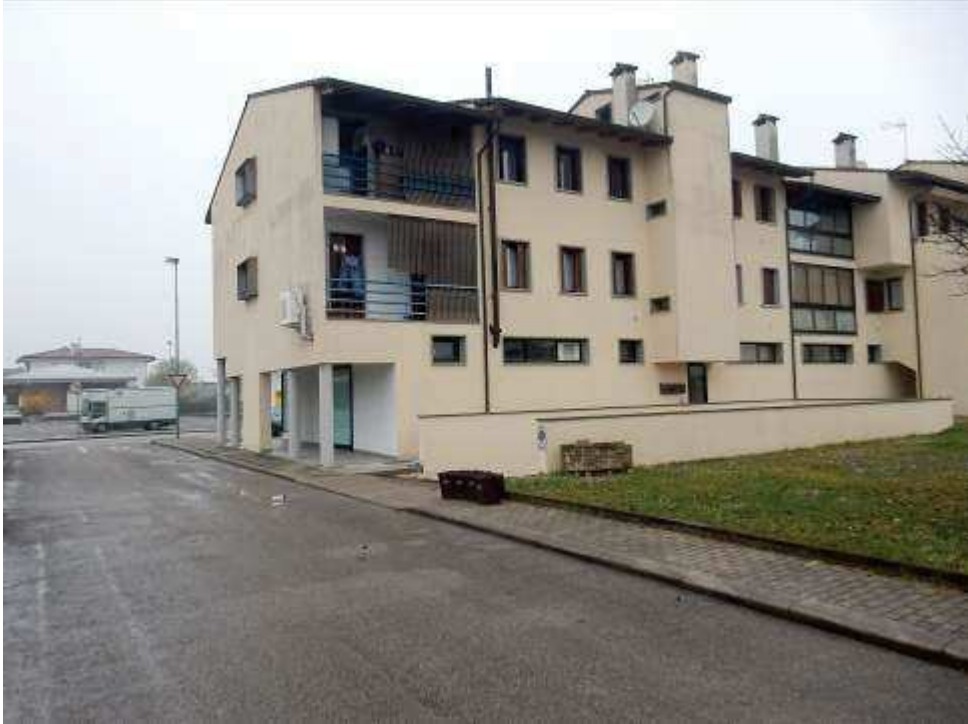
Foto 3-4: Fabbricato condominiale lato Est e lato Nord-Est.
