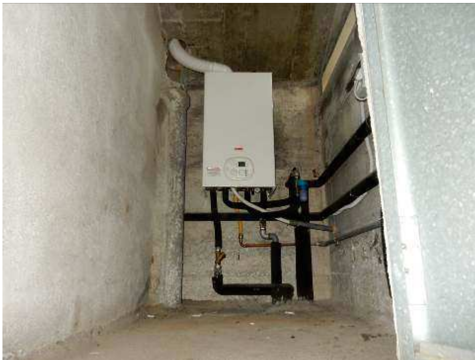
Foto 31-32: Locale vano tecnico e accesso.
