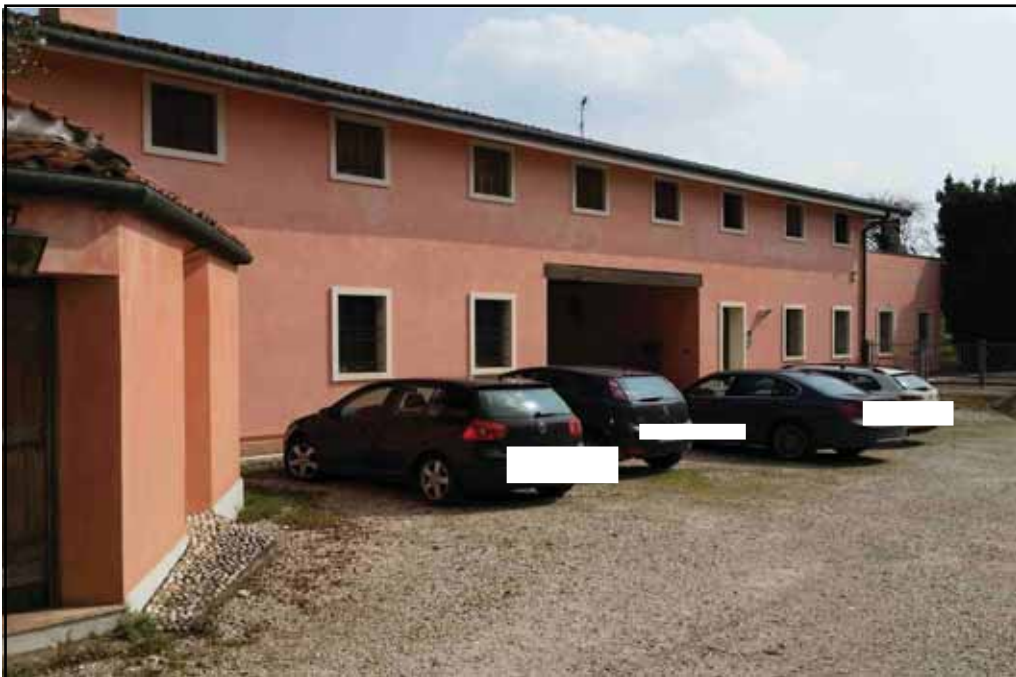
Particolare entrata da corte comune
