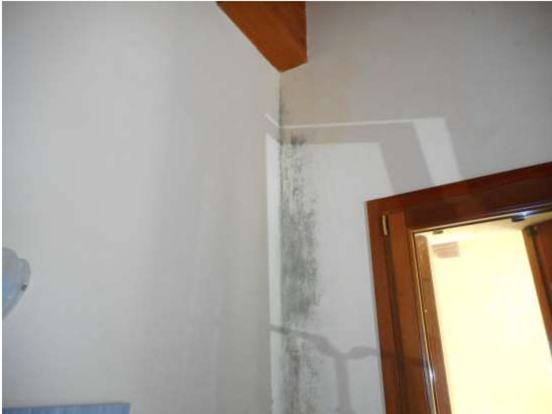
VISTA INTERNA - CAMERA P1°
