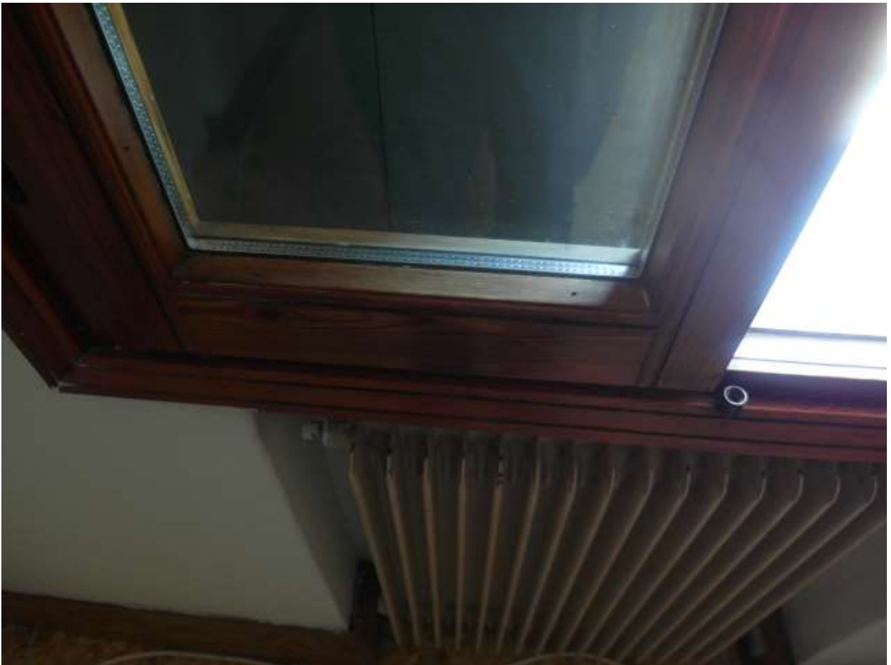
FOTO 11 • vista interna – particolare serramento
