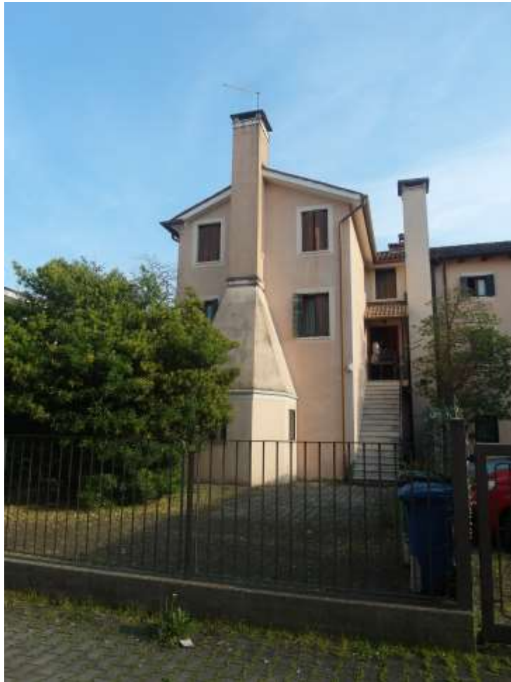
FOTO 2 • vista da Sud – scala d'accesso e area pertinenziale
