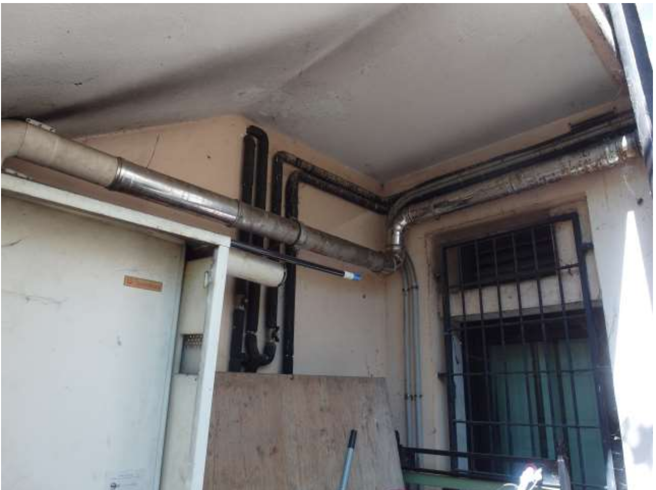
FOTO 19 • vista esterna – particolare caldaia installata sul sotto-scala
