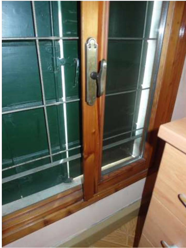
FOTO 18 • vista interna – particolare serramento
